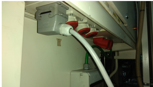
Figura 6.31: Tomada Harting conectada na máquina de injeção
