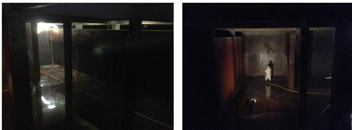
Figura 4.39 - Intervenção no Reservatório de Água Tratada
