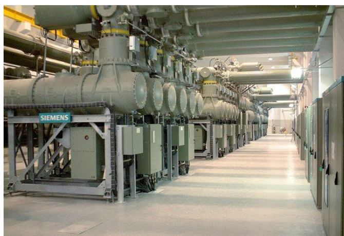
Figura 5 - GIS para montagem interior [7]
