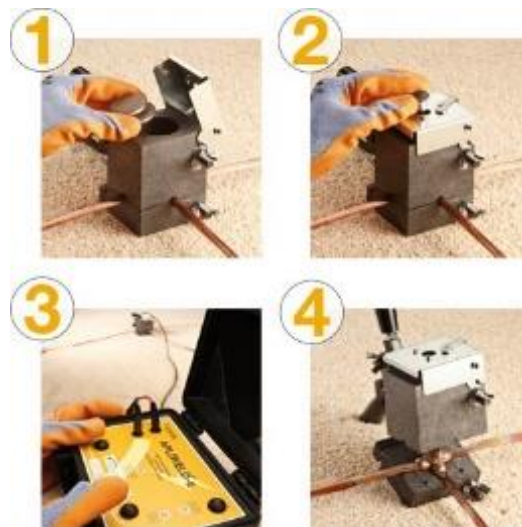
Figura 52 - Fases de execução de uma soldadura aluminotérmica [34]
