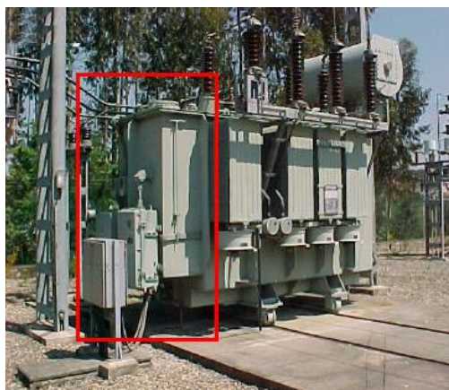
Figura 24 - Regulador de tensão em carga [18]
