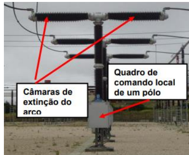
Figura 30 - Disjuntor de SF6 [23]
