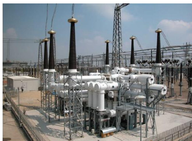
Figura 6 - GIS para montagem exterior [3]
