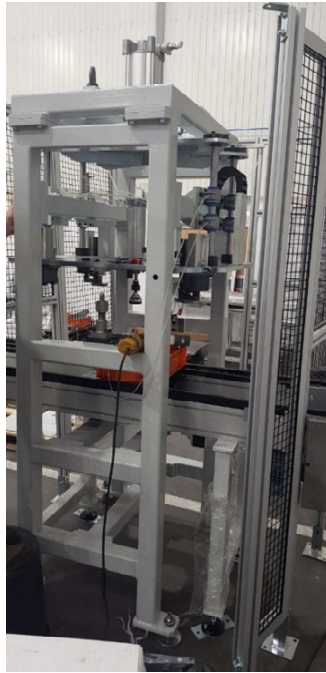
Figura 46 - Instalação do posto de aperto.
