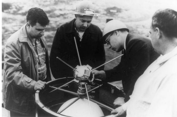
Figura 6.1 - Satélite Vanguard 1 montado no topo do foguete lançador [34].
