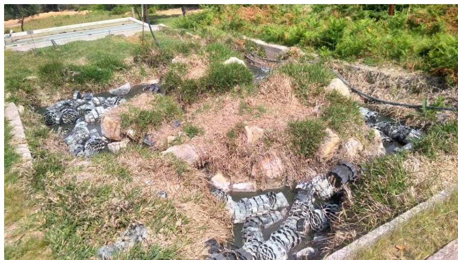
Figura 3.9 - Leitos percoladores com fitorremediação.
