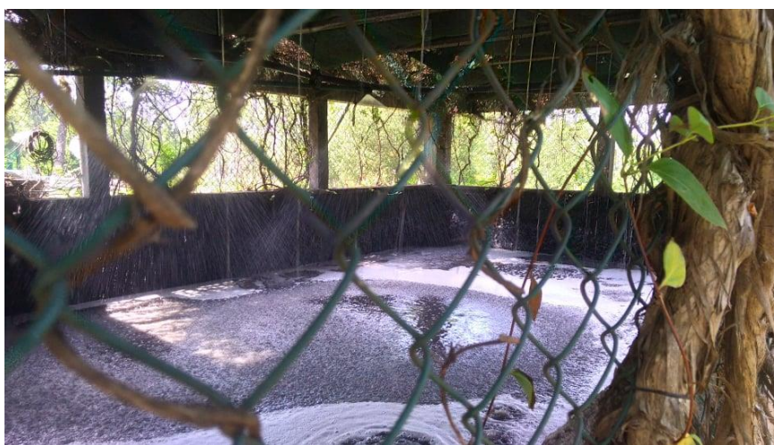
Figura 3.5 - Tanque de homogeneização.
