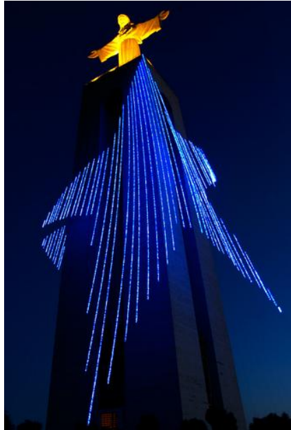
Figura 3.1 – ILUMINAÇÃO DECORATIVA NA TORRE DO CRISTO REI EXECUTADA PELA EMPRESA CASTROS,SA [castros.com.pt-2, 2012]
