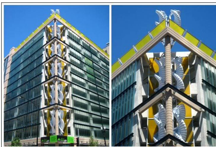
Figura 2.7 – AEROGERADORES DE EIXO VERTICAL INSTALADOS NO GREENWAY SELF PARK [designslinger.com, 2012]
