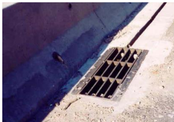
Figura 3.52 – Caleira/sumidouro com rasgo contínuo junto a separador central (Neves, 2020)
