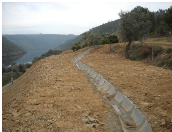
Figura 3.7 – Vala crista semi-circular revestida com betão (Nortejuvil Sociedade de Construção, 2020)
