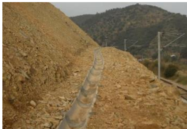
Figura 3.5 – Valeta de banqueteta semi-circular revestida com betão (Jacob, 2018)
