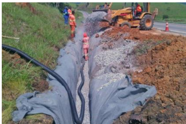
Figura 3.21 – Execução de dreno de rebaixamento (Jacob, 2018)
