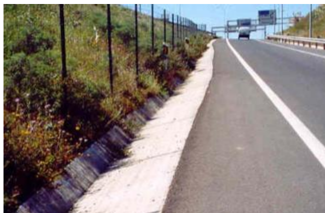
Figura 3.1 – Valeta de plataforma lateral de secção triangular revestida a betão (Neves, 2020)
