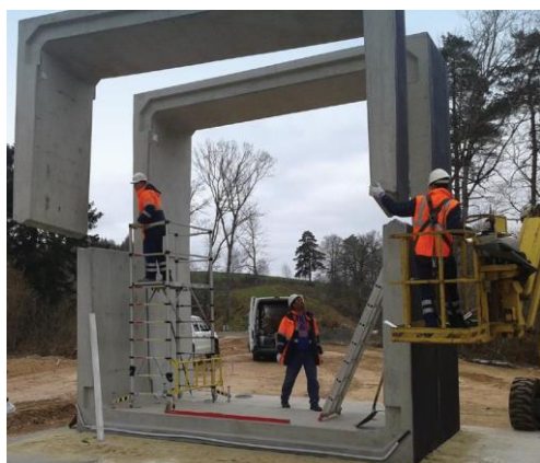
Figura 3.12 – Montagem de box-culvert (Motaengil, 2020)
