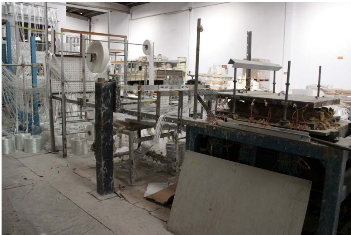
Figura 31 - Vista geral do equipamento
