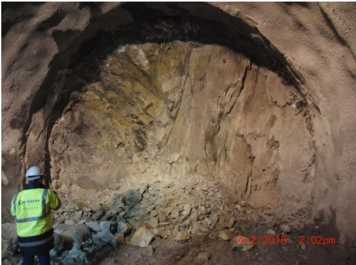
Figura 1. Aspecto da envolvente das cartografias geológico-geotécnicas de frentes de escavação do túnel.
