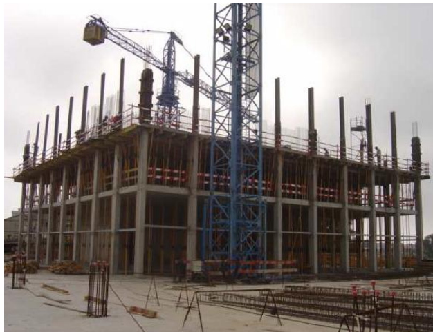
Figura 1.4 – Edifício Burgo em fase construtiva.
