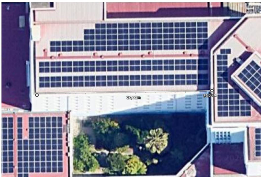
Figura 3.3: Medição da fachada do HDM no Google Maps.
