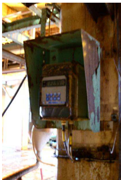
Figura 7.11 - Situação actual dos condutivímetros nos digestores descontínuos.
