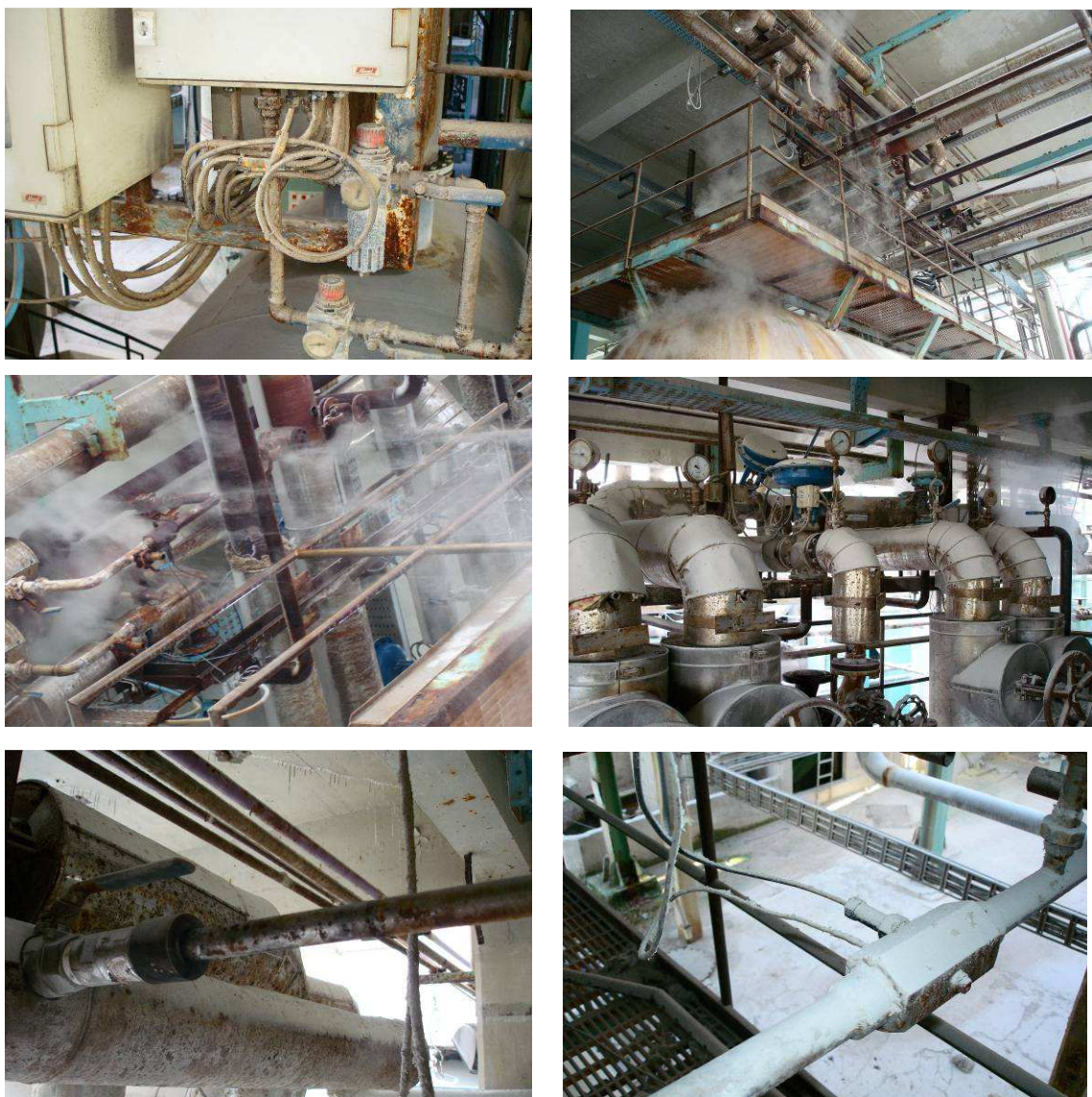
Figura 7.12 - Estado de conservação do tanque de condensados do branqueamento e dos condutivímetros instalados em linha.
