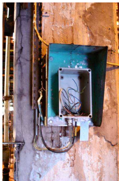
Figura 7.11 - Situação actual dos condutivímetros nos digestores descontínuos.
