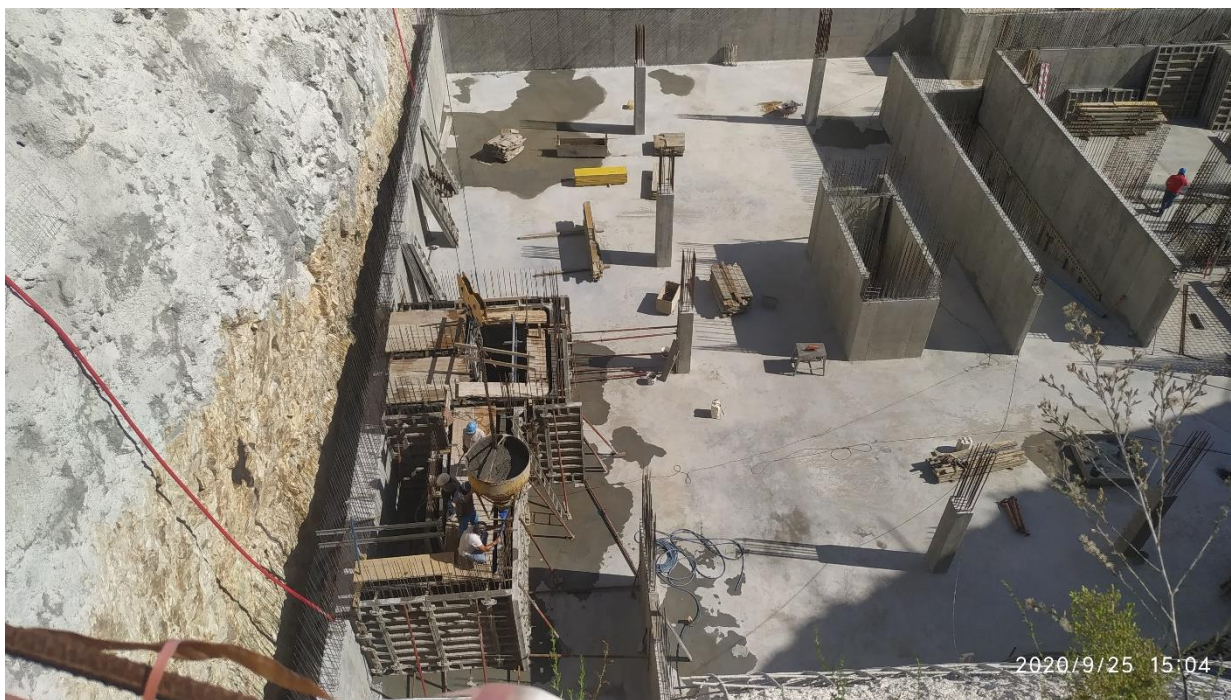
Figura 8.10 betonagem direta (sem bombagem)
