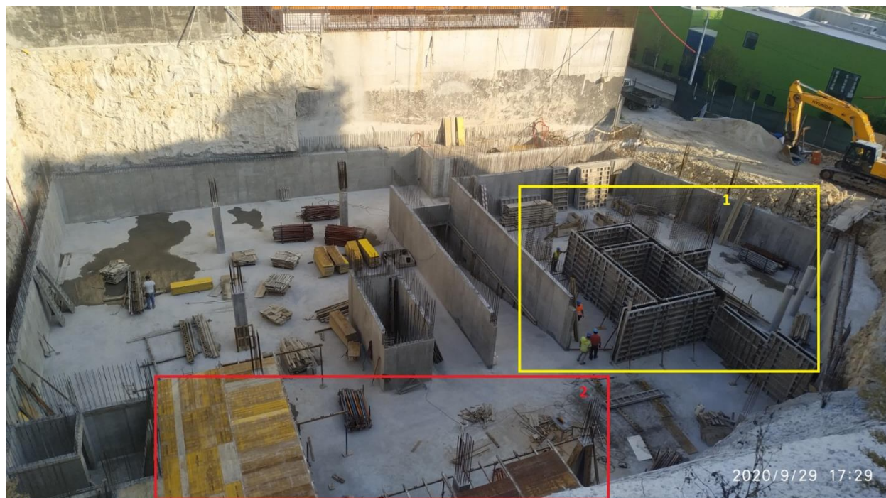
Figura 8.9 execução da obra
