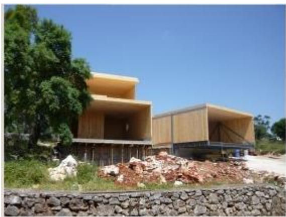
Figura 8.3 Casa unifamiliar (2009); Alcanena
