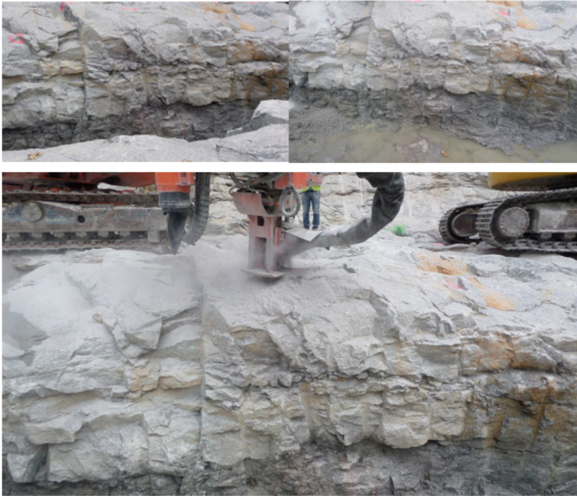
Figura 124. Maciço rochoso a partir da vala de drenagem, do local onde foi executada a perfuração, referente ao terceiro ciclo de afiação.
