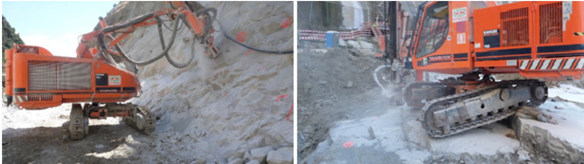
Figura 32. Equipamentos de perfuração utilizados (cortesia: Água é Vida Captações, Lda).
