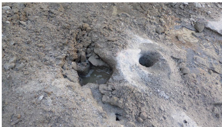
Figura 68. Exemplo de um mau emboquilhamento (esquerda) e bom emboquilhamento (direita).
