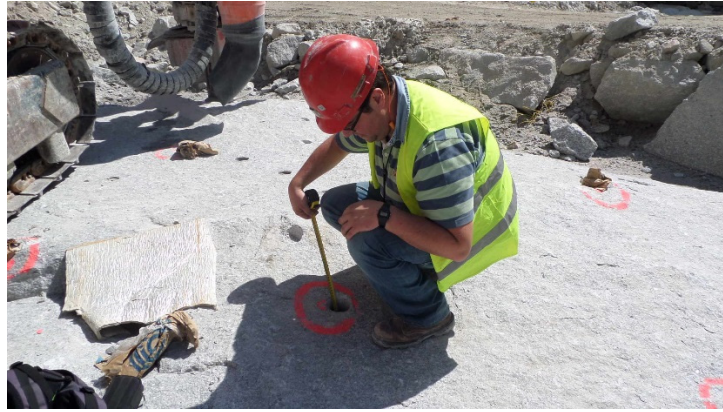
Figura 69. Validação do comprimento do furo.
