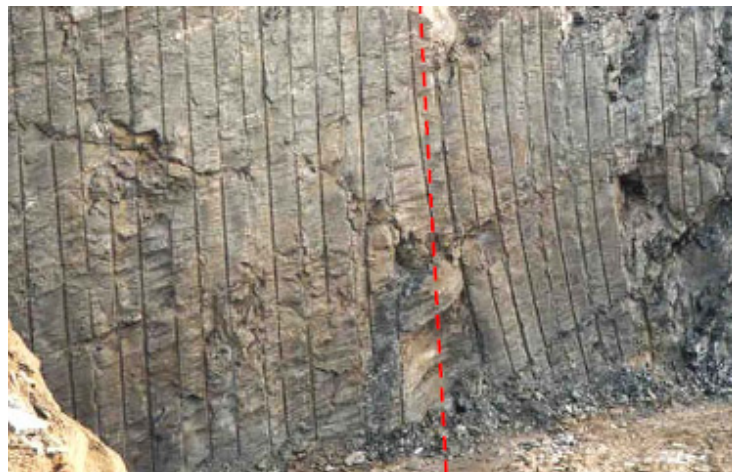
Figura 40. Flexão na perfuração com e sem vara guia ( www.quarryacademy.com ).
