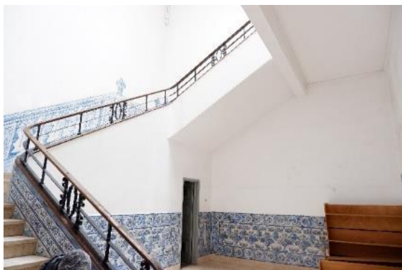
a) Caixa de escadas principal
