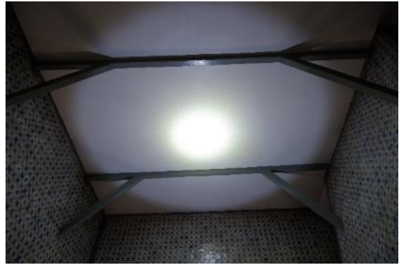
b) Estrutura de madeira visível no teto da antiga cozinha (piso 0)
