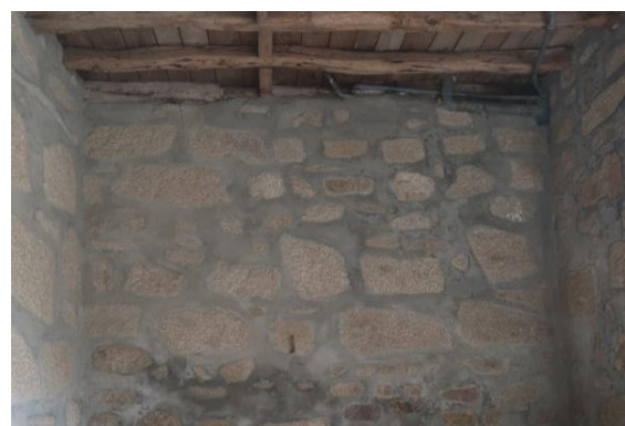
Figura 5.12 – Manchas de humidade e argamassa cimentícia nas paredes de alvenaria de pedra
