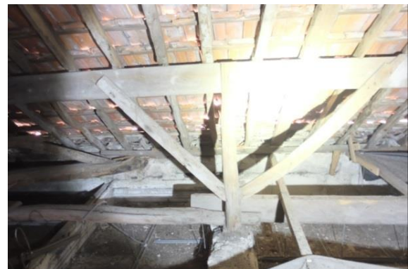
Figura 5.10 – Alçado (sem escala) e registo fotográfico do alinhamento de escoras
