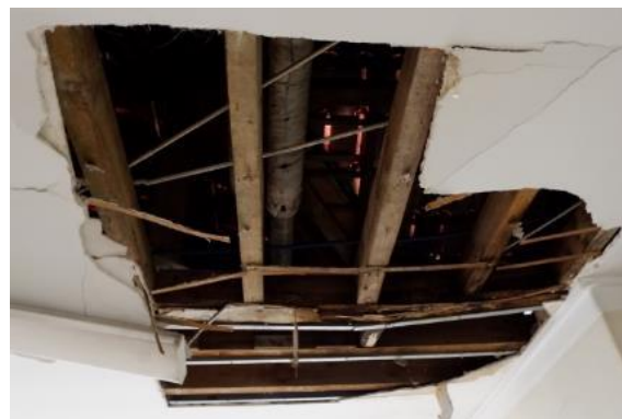
d) Vigas de madeira que constituem o teto do piso 2 do edifício lateral
