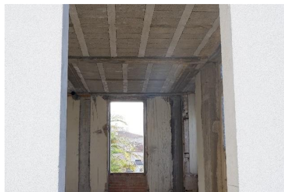
Figura 3.1 – Exemplo de “fachadismo”: reconstrução total do interior com solução nova em betão
