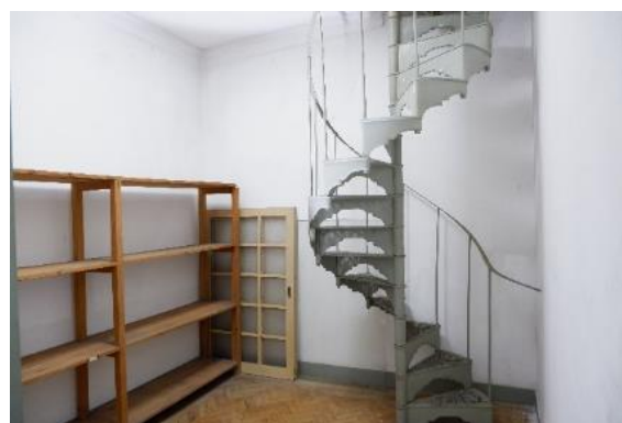
b) Escadas em estrutura metálica
