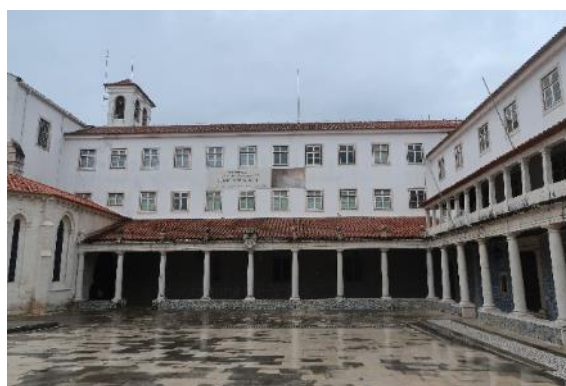
b) Fachada nascente (atual)
