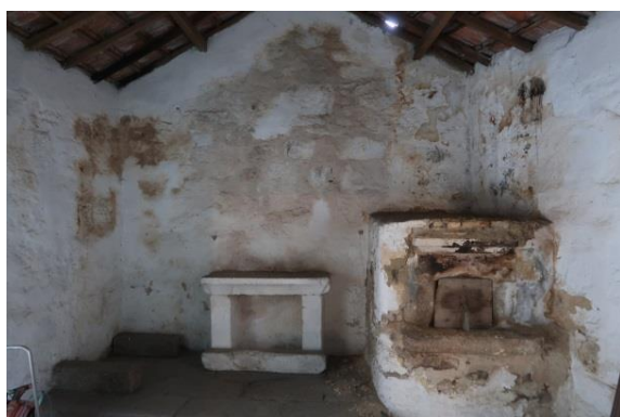
Figura 5.12 – Manchas de humidade e argamassa cimentícia nas paredes de alvenaria de pedra
