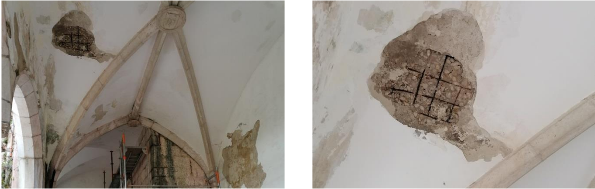
Figura 4.37 – Exemplo de elemento em betão armado existente nas abóbadas do Claustro Novo (ala sul) (fonte: Câmara Municipal de Odivelas)
