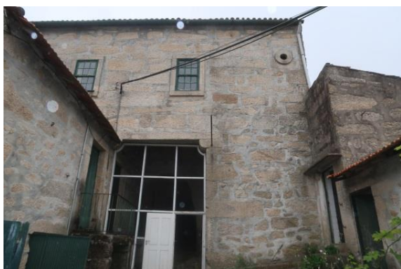
a) Fachada posterior e anexos
