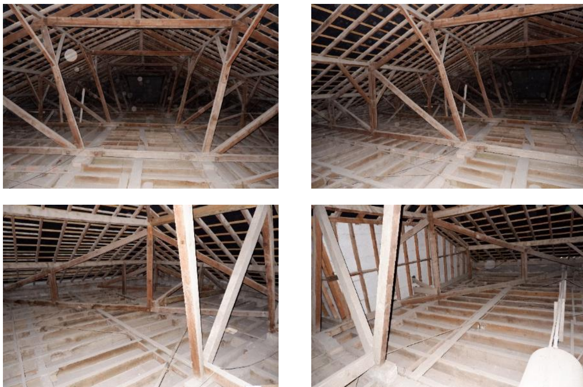
Figura 4.23 – Fotos gerais da estrutura da cobertura do corpo 2
