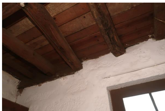
b) Parede interior (piso 0)
