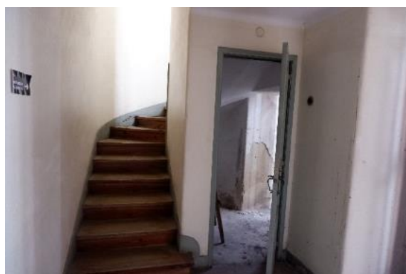
a) Caixa de escadas principal
