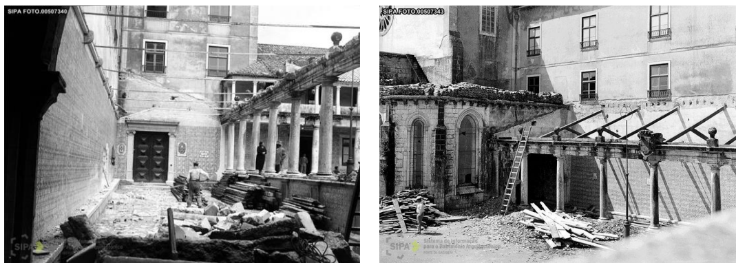
Figura 4.7 – Registo fotográfico da reconstrução da cobertura do alpendre da entrada, em 1949-50 [39]
