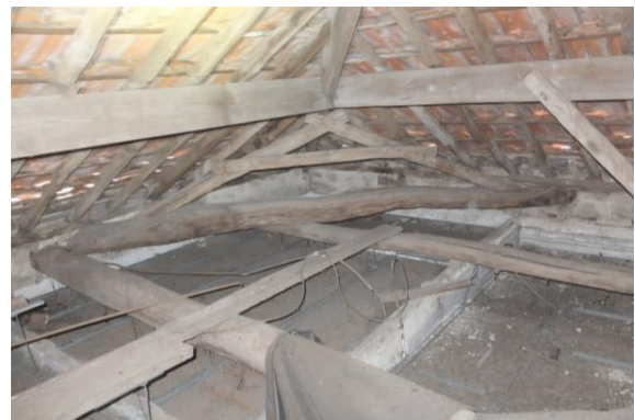
Figura 5.9 – Alçado (sem escala) e registo fotográfico da asna secundária
