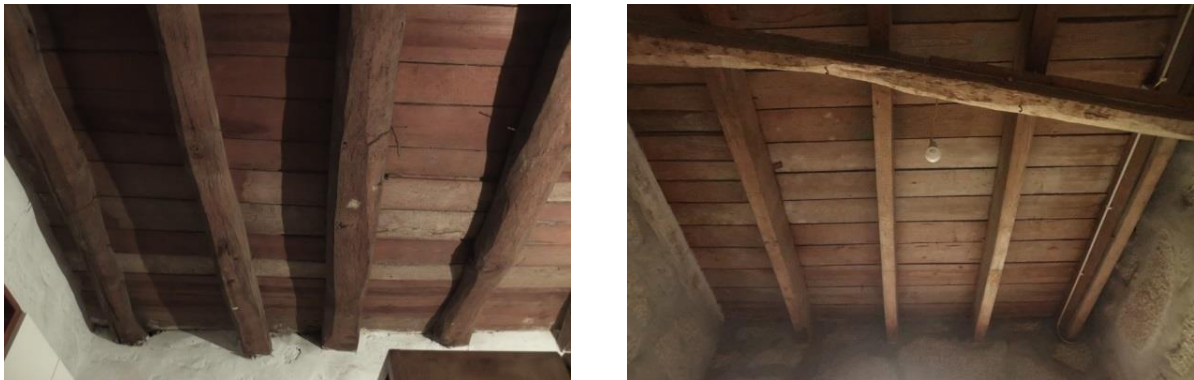
Figura 5.6 – Exemplos de vigas de pavimento existentes
