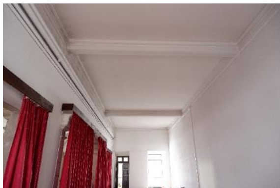
c) Vigas em betão que constituem o teto do coro-alto
