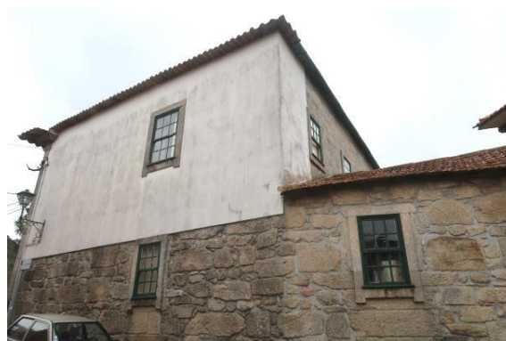
a) Fachada lateral (alçado sudoeste)
