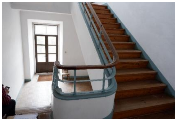
b) Caixa de escadas existente na zona nascente
