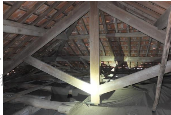
Figura 5.8 – Alçado da asna principal (sem escala) e registo fotográfico da asna A2
