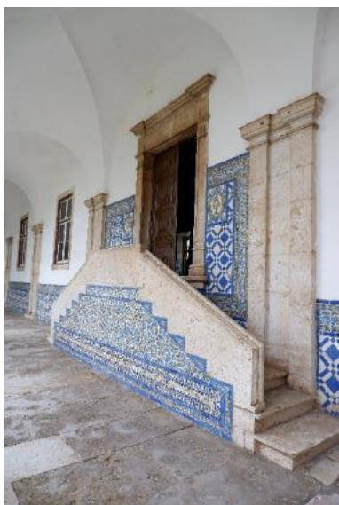
a) Escadas de acesso ao refeitório (piso 0)
