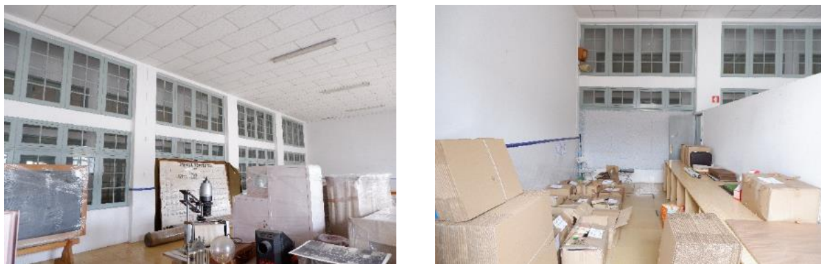
Figura 4.21 – Fotos gerais dos pórticos em betão armado existentes no interior do edifício
