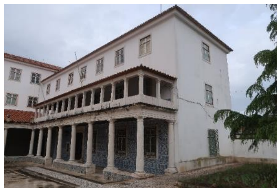
b) Fachada sul (atual)
