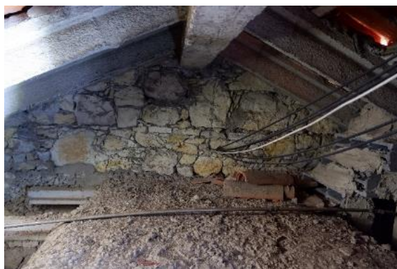
a) Exemplos de paredes existentes em alvenaria de pedra
