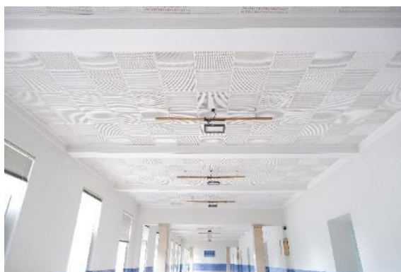
Figura 4.31 – Exemplos de elementos em betão armado que constituem a estrutura do corpo 7
