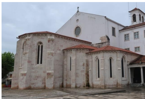
b) Vista geral sobre a cabeceira da igreja
