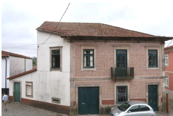
a) Fachada principal (alçado noroeste)
