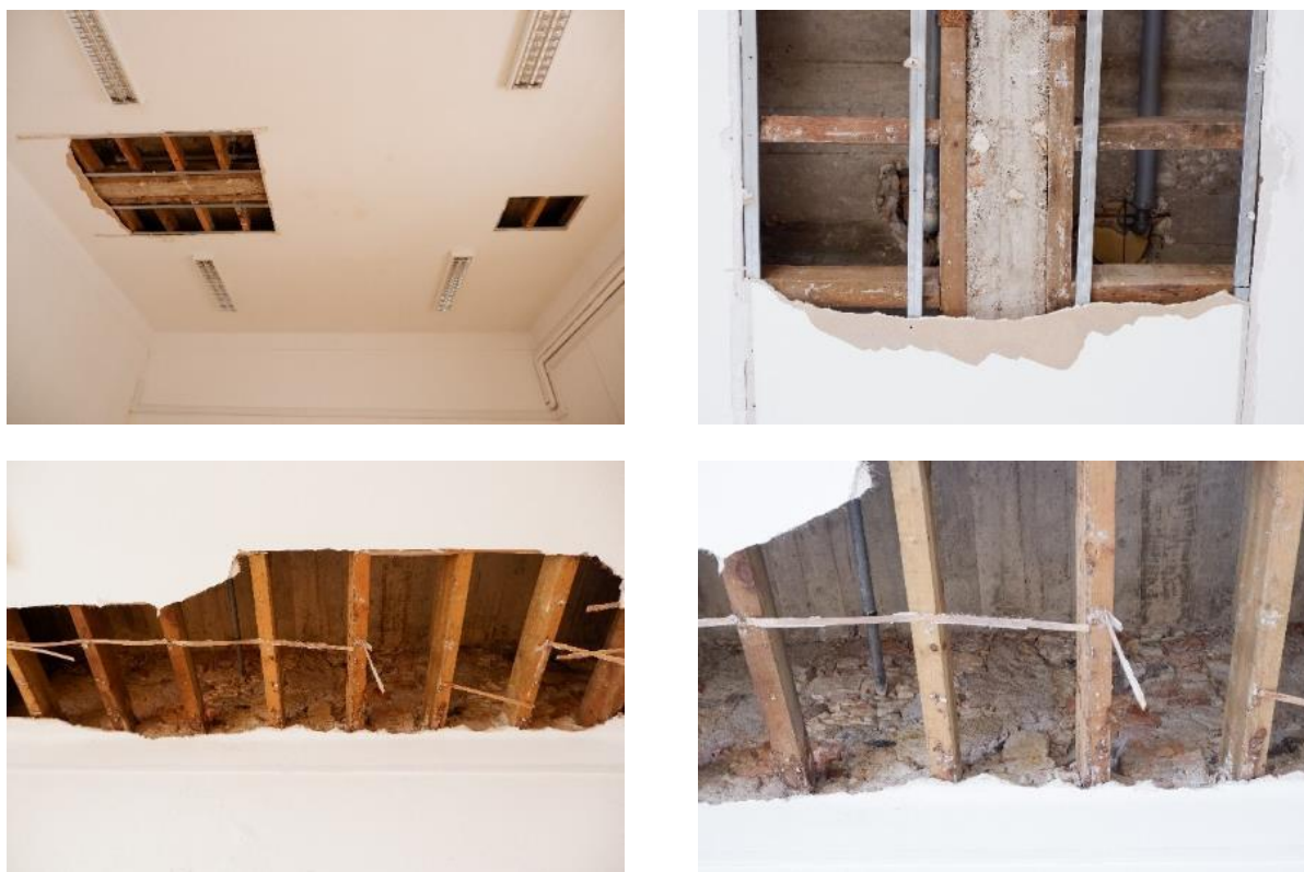
Figura 4.22 – Exemplos de elementos horizontais que constituem o pavimento do piso 2 (teto do piso 1)
