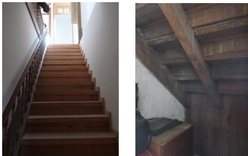
a) Escada junto à entrada principal
