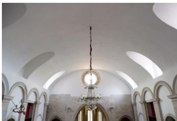
b) Teto da nave da igreja
