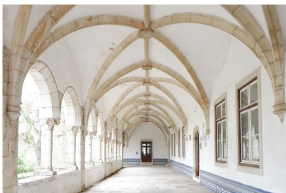
a) Abóbadas de cruzaria com nervuras existentes nas alas sul e poente
