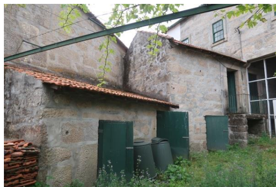
d) Anexos na zona posterior do edifício
