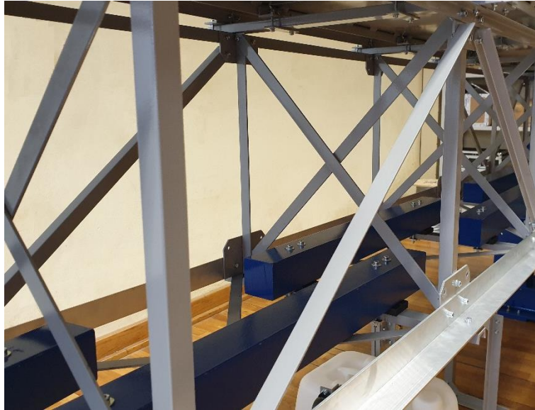
Figura 4.11 – Barras de aço e tanques de água aplicados ao nível da corda inferior
