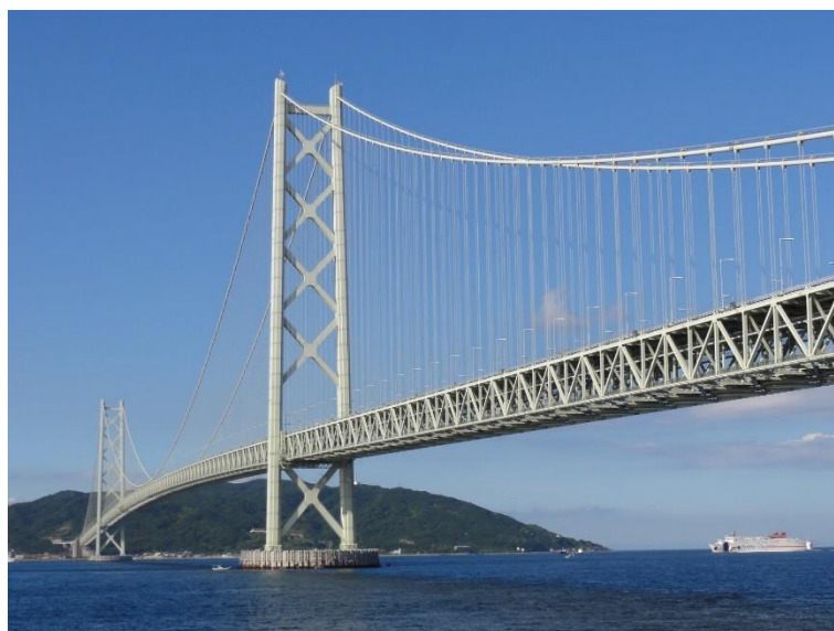
Figura 2.7 – Ponte Akashi-Kaikyo (rodoviária e ferroviária)
