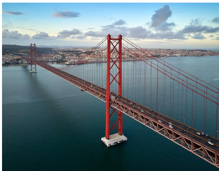
Figura 2.10 – Ponte 25 de Abril (rodoviária e ferroviária)
