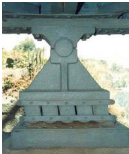
Figura 2.14 – Apoio móvel
