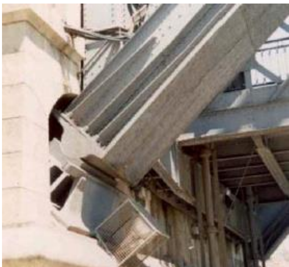
Figura 2.13 – Apoio fixo
