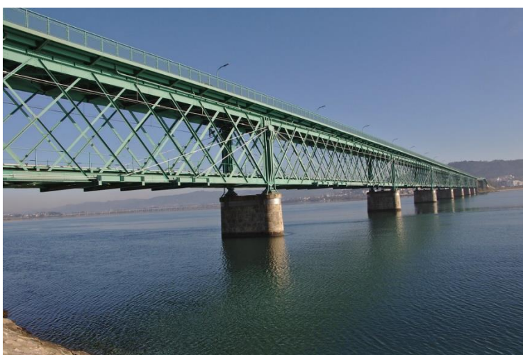
Figura 2.9 – Ponte Eiffel sobre o rio Lima (rodoviária e ferroviária)
