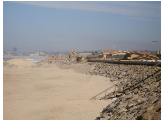
Intervenção finalizada na extremidade Sul
