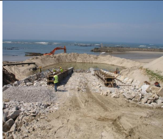
Enrocamento de fundação e colocação de armaduras nas guias da rampa
