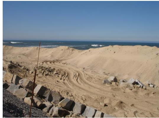
Dique de proteção e colocação da segunda camada de enrocamento
