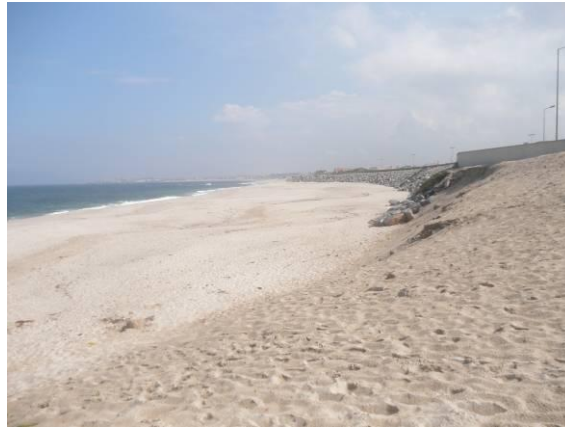
Vista da estrutura aderente Sul-Norte
