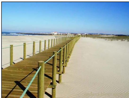
Figura 18 - Passadiço entre Granja e Espinho (Ondas3).
