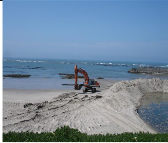
Terraplenagem para construção do dique de proteção
