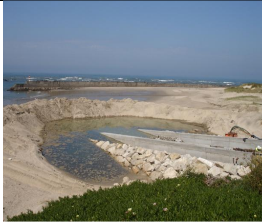
Talude em enrocamento e betonagem parcial das guias da rampa
