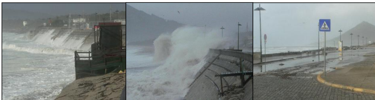
a) Destruição de infraestruturas; b) Galgamento; c) Inundação.
