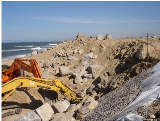
Manto geotêxtil coberto de brita e colocação da primeira camada de enrocamento
