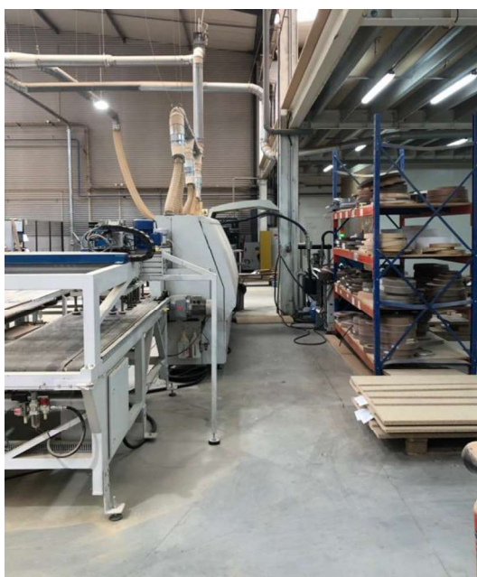
Figura 26 – Zona de Acesso a Rack de Orlas
