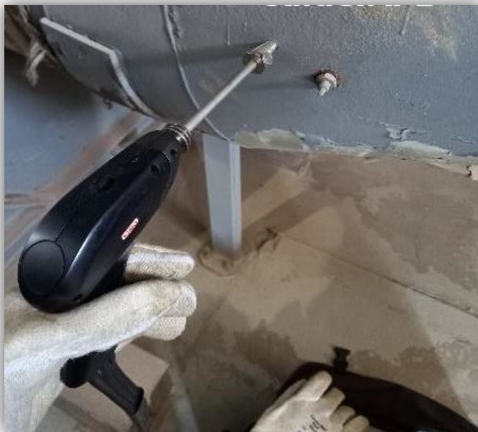
Figura 7 - Medição dos gases de exaustão.
