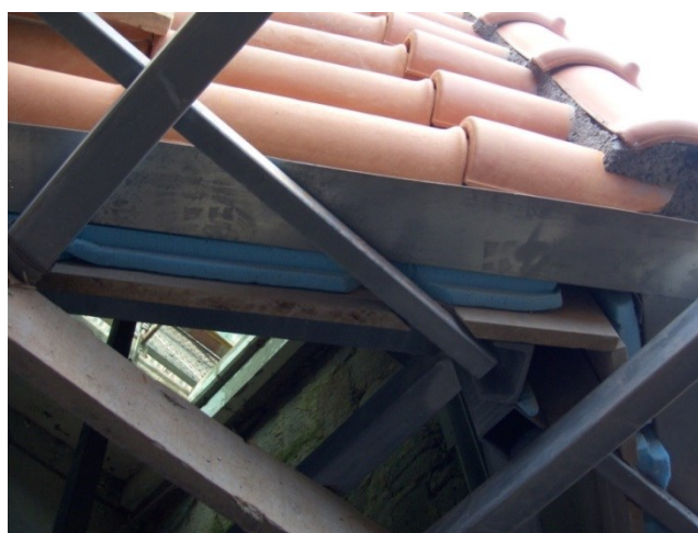
Figura 102 Pormenores da cobertura
