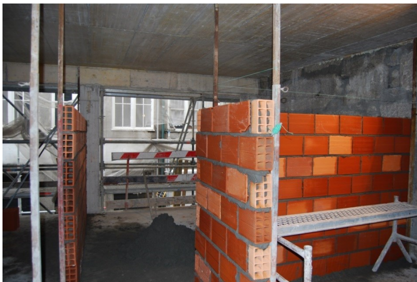
Figura 44 Execução da parede de alvenaria de tijolo - Fonte: Porto Vivo, SRU
