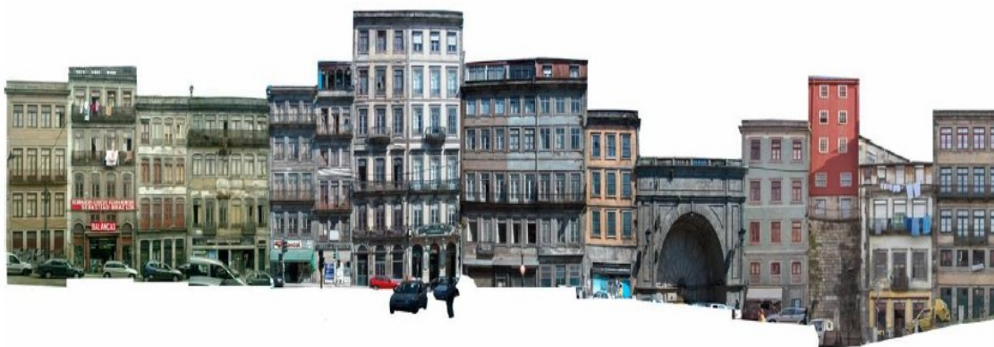
Figura 14 - Corpo da Guarda na Rua Mouzinho da Silveira –Fonte: Documento Estratégico para o quarteirão corpo da guarda
