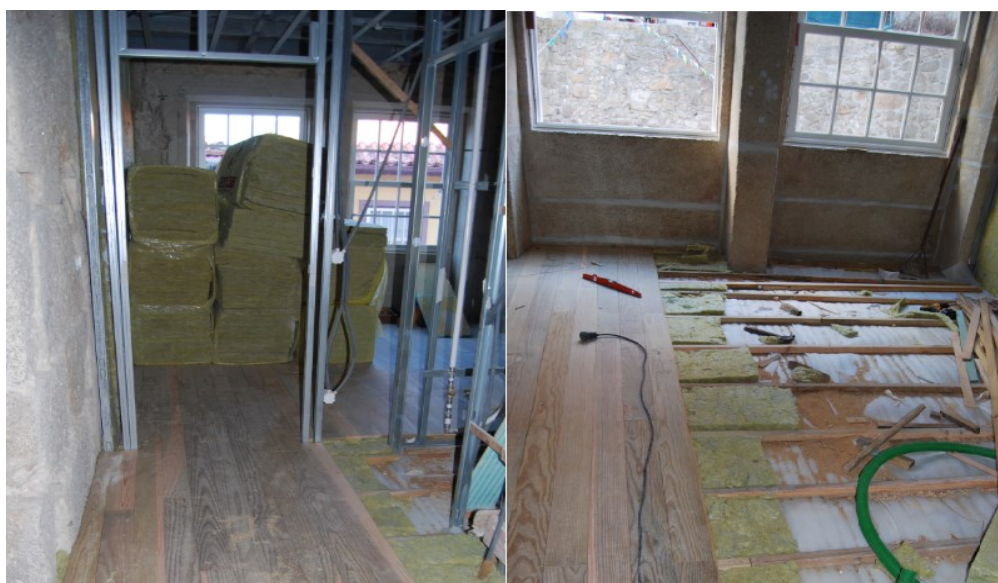
Figura 114 Colocação do pavimento - Fonte: Porto Vivo, SRU
