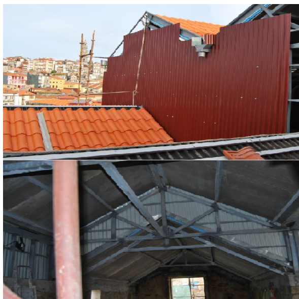
Figura 103 Colocação das chapas no recuado
