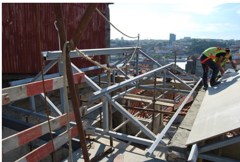
Figura 74 Execução da cobertura - Fonte: Porto Vivo, SRU
