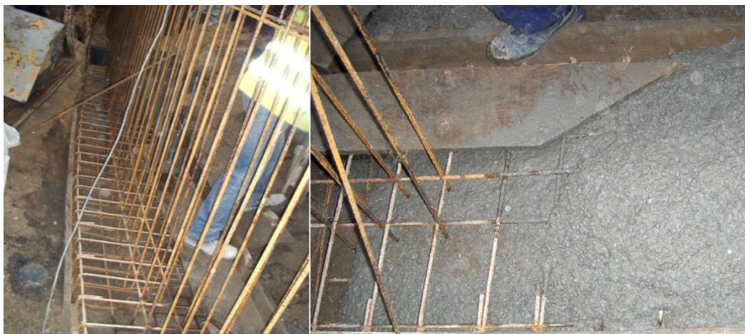
Figura 52 Betonagem da parede da caixa horizontal comum da operação F
