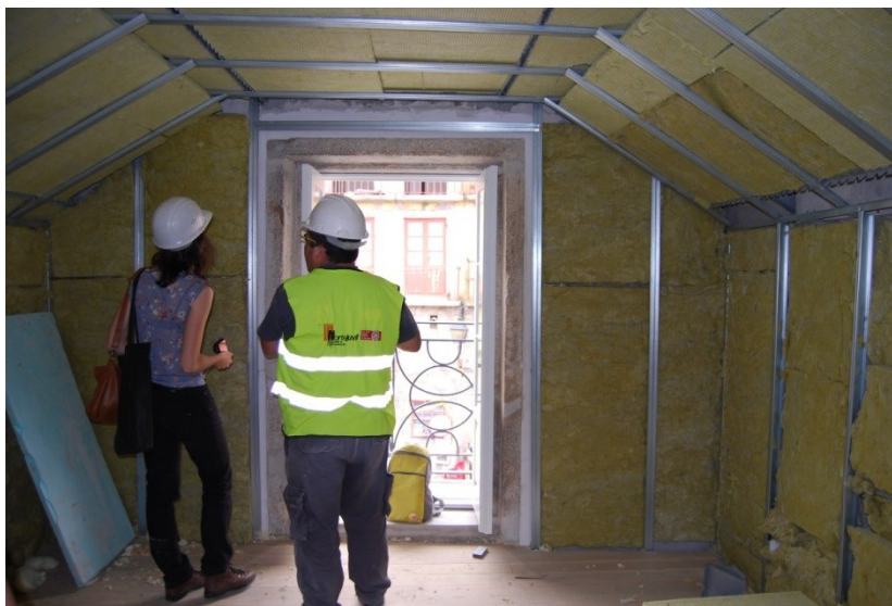
Figura 115 Preenchimento das paredes interiores com lã de rocha
