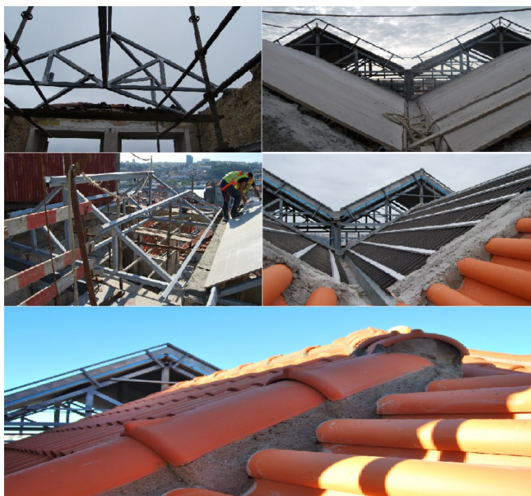
Figura 101 Execução da Cobertura – Fonte: Site Porto Vivo, SRU
