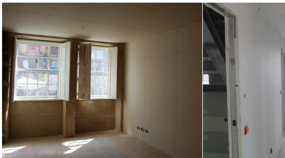
Figura 116 Paredes interiores - Fonte: Porto Vivo, SRU
