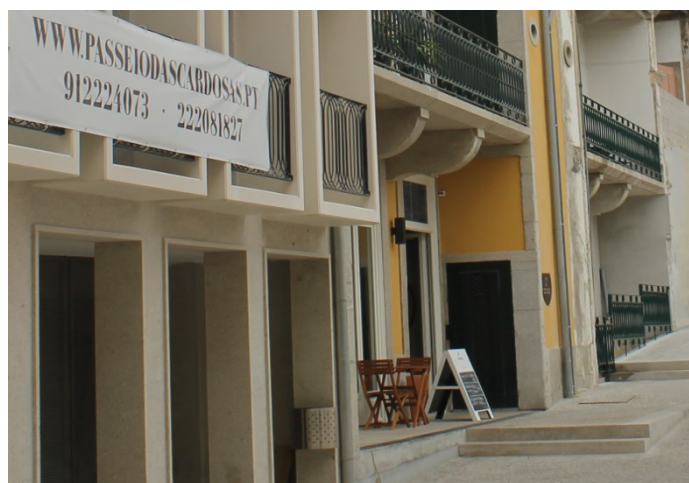
Figura 25 Restauração no R/C de um edifício de habitação no interior do quarteirão das Cardosas
