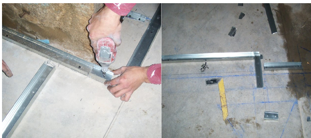
Figura 105 Preparação do sistema de tabiques
