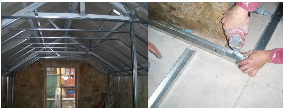
Figura 70 Montagem do sistema de tabiques com estrutura metálica do tipo KNAUF
