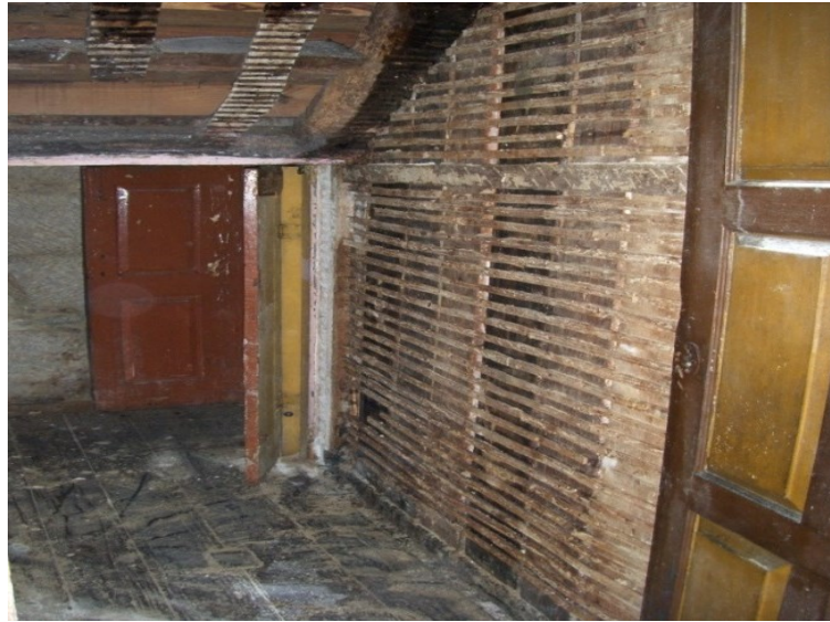
Figura 5 Parede interior em tabique
