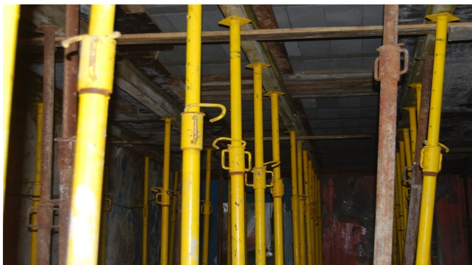
Figura 53 Escoramento dos pisos e das vigas
