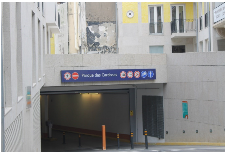
Figura 28 Parque de estacionamento subterrâneo no interior do Quarteirão das Cardosas
