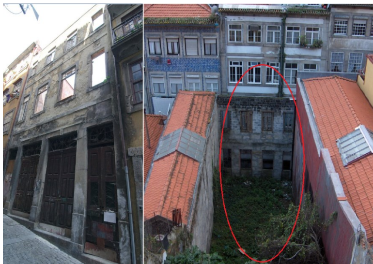
Figura 41 Operação B antes da intervenção - Fonte: Porto Vivo, SRU
