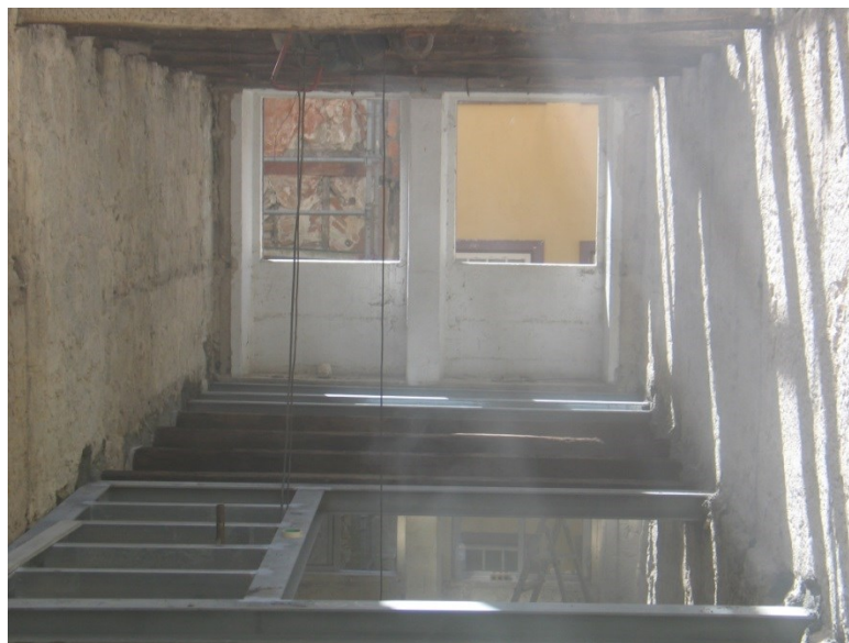
Figura 71 Estrutura original complementada com elementos de aço com vigas de madeira (aproveitada da original) - Fonte: Porto Vivo, SRU
