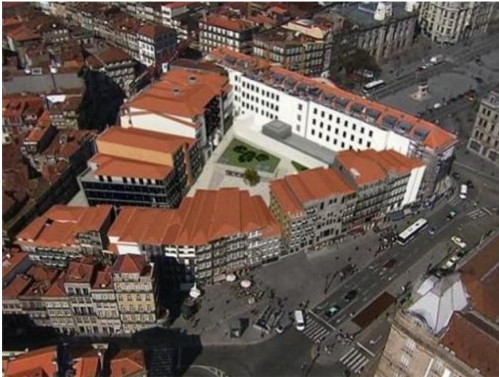
Figura 30 Passeio das Cardosas depois da intervenção – Fonte: Google Images
