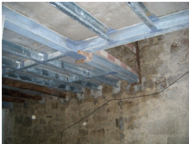
Figura 72 Malha metálica de perfis em U
