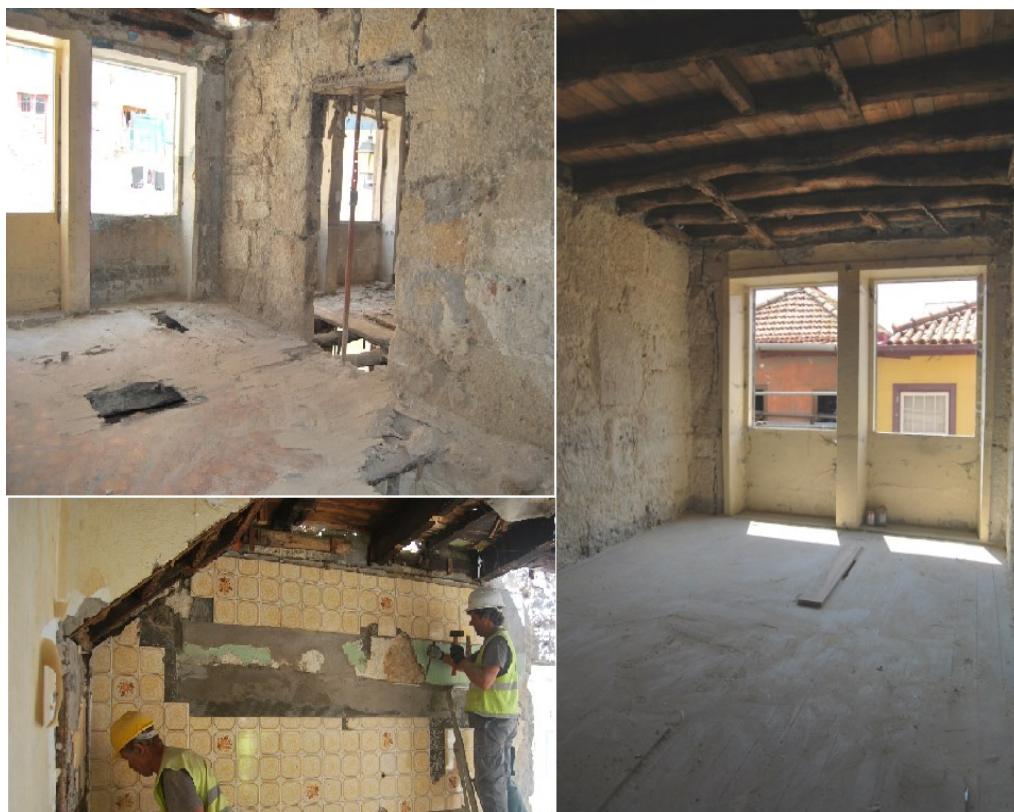
Figura 97 Remoção e limpeza das parcelas
