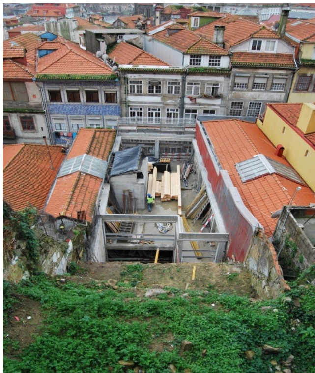
Figura 43 Fase de estruturas da operação B – Fonte: Porto Vivo, SRU
