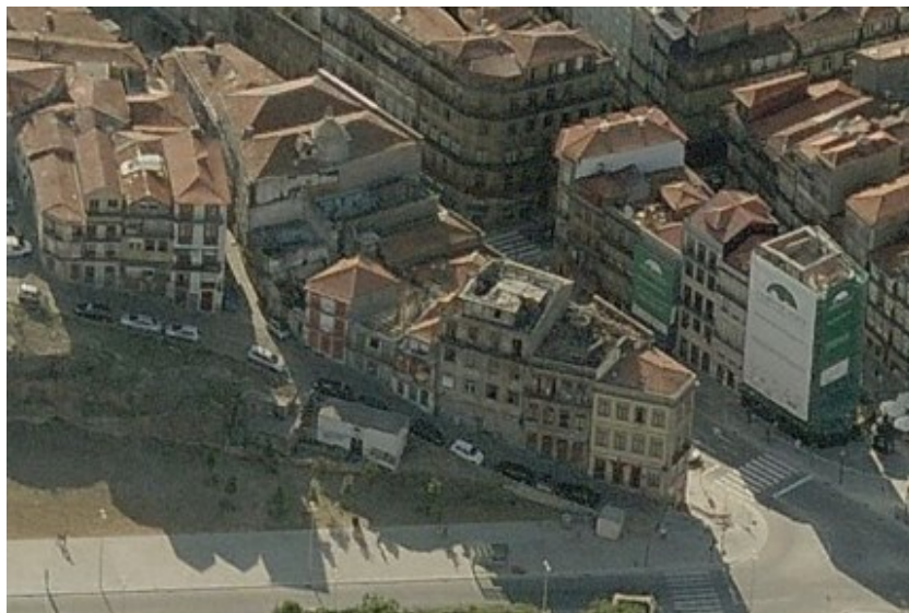
Figura 16 Corpo da guarda - edifícios construídos sobre escarpa granítica - Fonte: Google imagens
