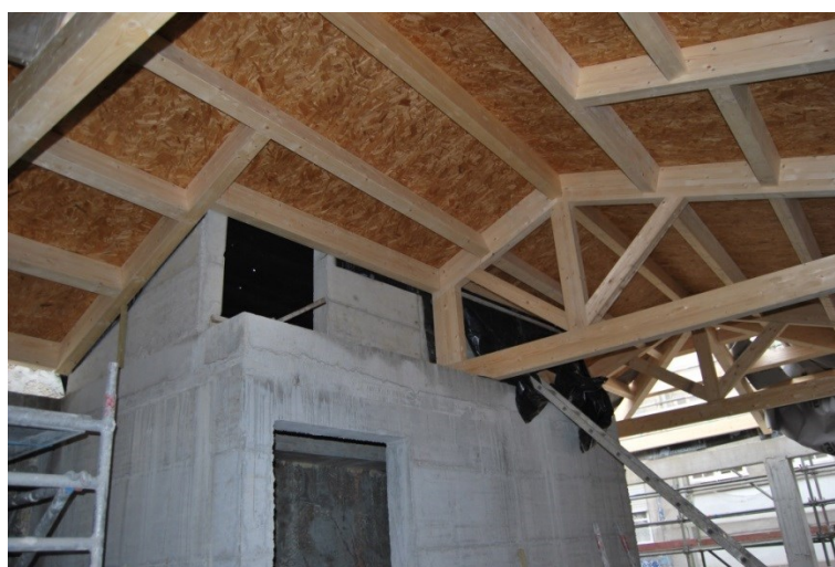
Figura 45 Execução da cobertura - Fonte: Porto Vivo, SRU
