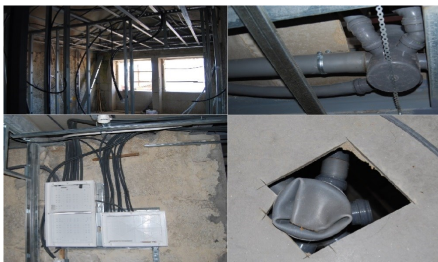
Figura 108 Colocação das infraestruturas
