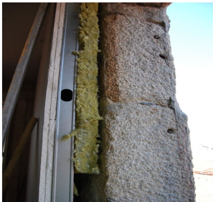
Figura 117 Pormenor da parede exterior - Fonte: Porto Vivo, SRU
