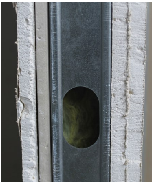
Figura 119 Pormenor das paredes divisórias
