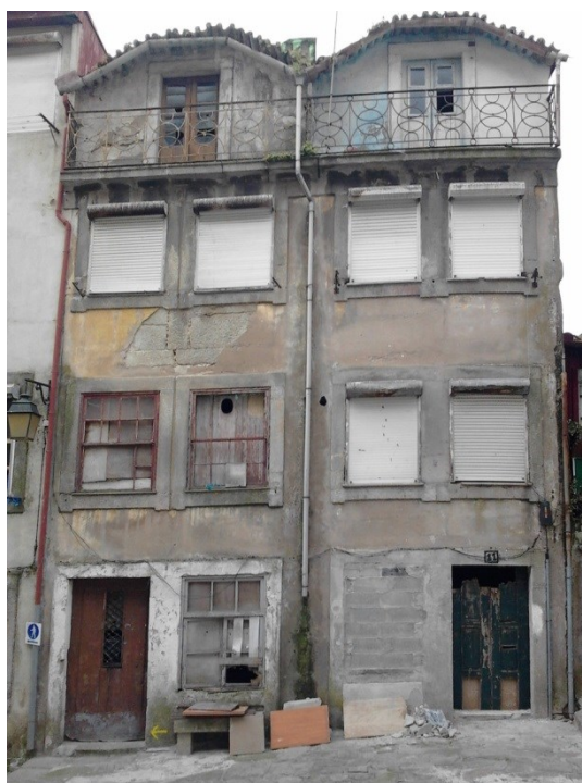
Figura 61 Fachada traseira dos edifícios a reabilitar - Largo de Penaventosa
