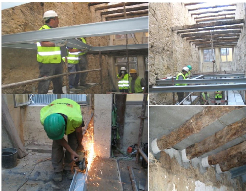
Figura 98 Colocação das Vigas metálicas e aproveitamento das vigas de madeira pré-existentes – Fonte: Site da Porto Vivo, SRU
