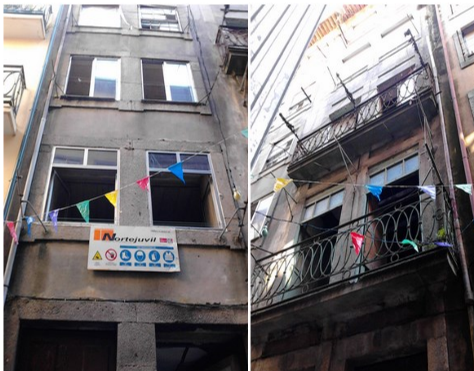
Figura 60 Fachada principal dos edifícios a reabilitar - Rua de Sant`Ana
