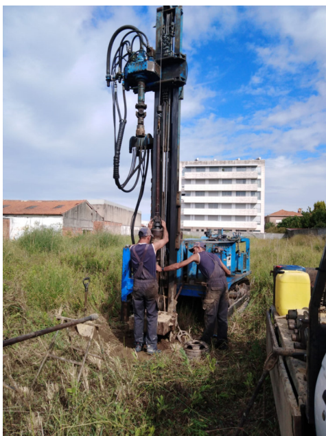
Fotos 2.1: Equipamento SMA no local da sondagem S2.
