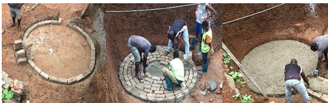
Figura 12 – Fases finais da construção da base. Fonte: Projeto Bio&Energy
