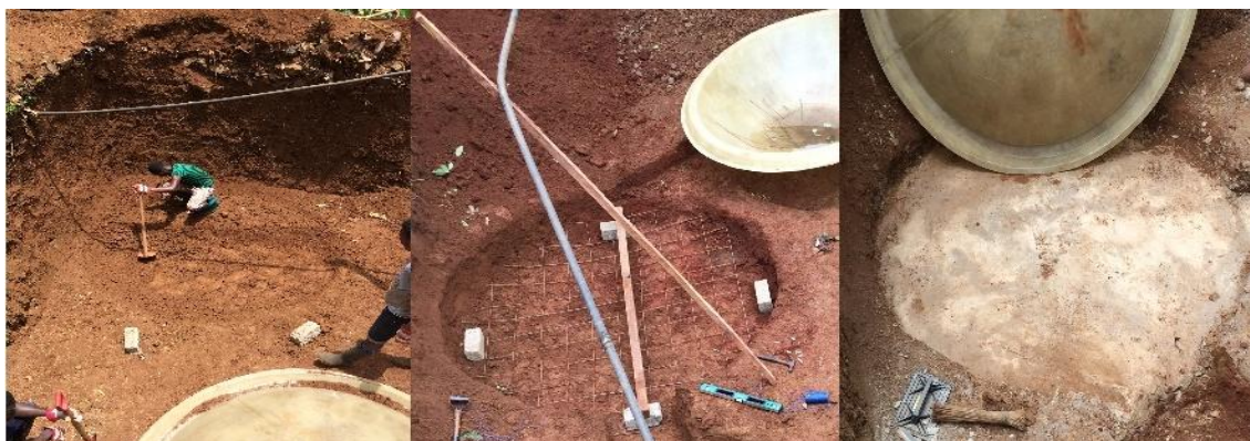
Figura 11 – Fases iniciais da construção da base. Fonte: Projeto Bio&Energy
