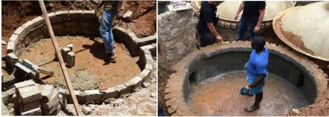
Figura 13 – Construção da parede. Fonte: Projeto Bio&Energy
