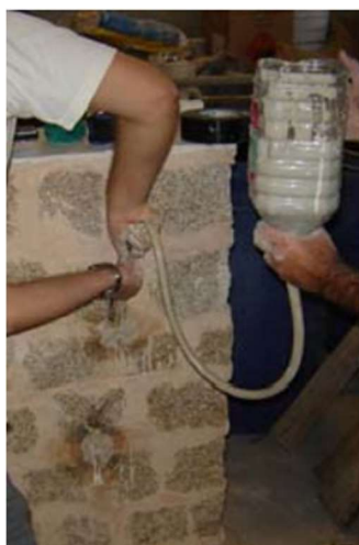
a) injeção por gravidade
