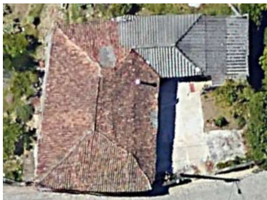
Figura 3.18 - Vista aérea da cobertura do edifício (google earth).
