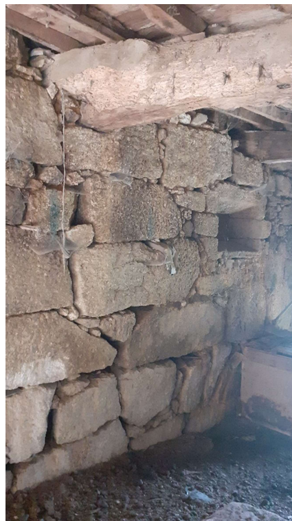
Figura 4 - Face interior do alçado lateral esquerdo.
