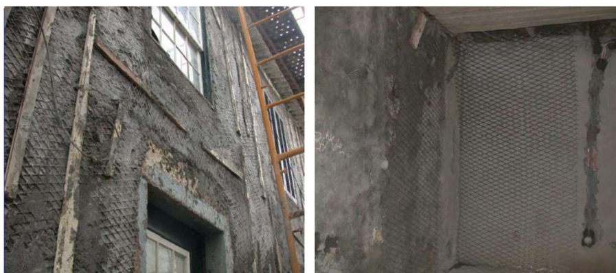
Figura 2.29 - Aplicação de reboco armado (Rodrigues, 2010).
