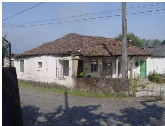
Figura 3.19 - Cobertura do edifício (vista do arruamento).
