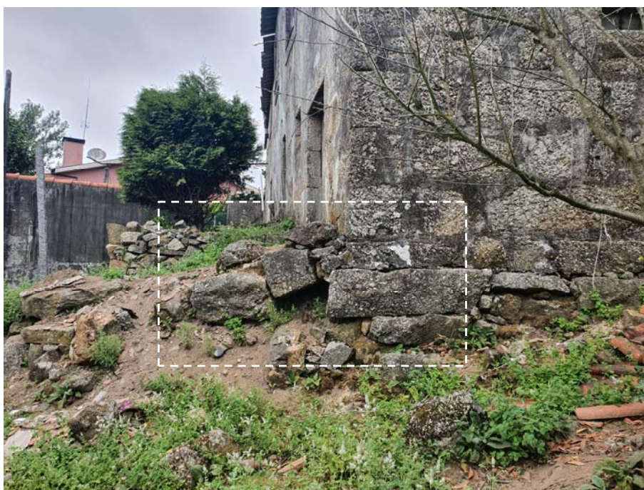
Figura 1- Descalçamento e assentamento da fundação – encontro das fachadas a noroeste e a sudoeste do edifício.
