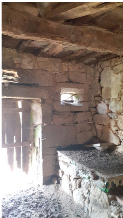
Figura 1 – Face interior do alçado posterior em alvenaria de pedra.
