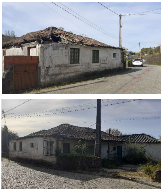
Figura 3.2 - Alçado principal do edifício - vista da Rua de São Paio.
