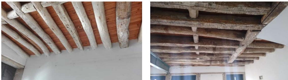
Figura 2.8 – Pavimento de madeira tradicional (fotos cedidas pela Dr. Building).
