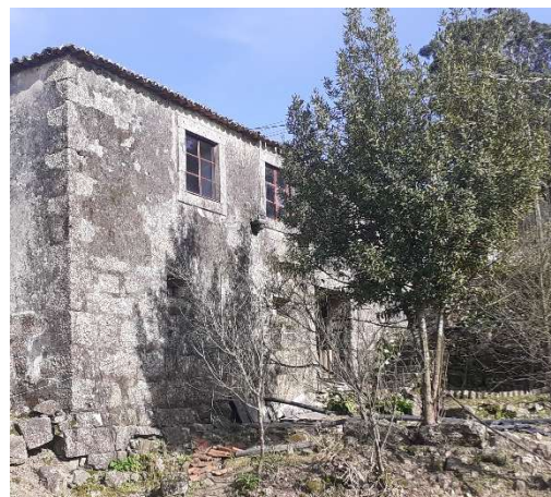
Figura 3.22 - Fachada lateral esquerda do edifício.
