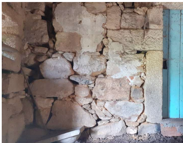
Figura 3.25 – Parede de compartimentação da cave.
