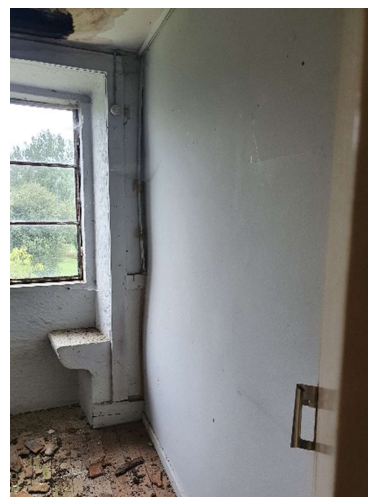
Figura 3.26 – Parede de compartimentação da habitação 2.
