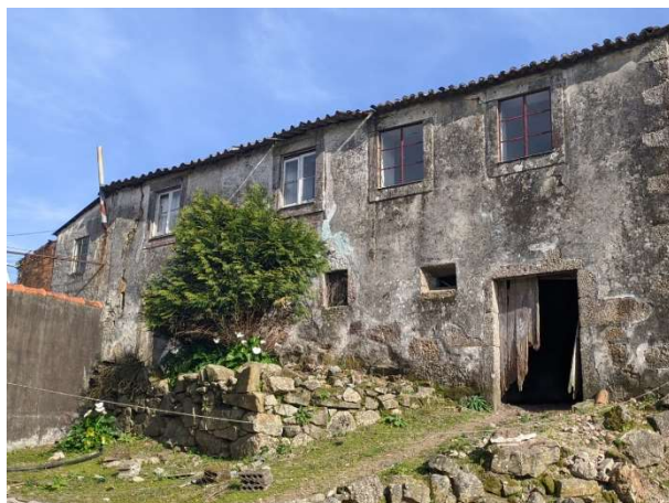
Figura 3.21 - Fachada posterior do edifício.
