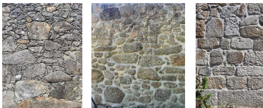
a) Alvenaria irregular e aleatória
