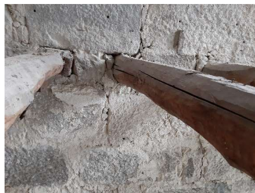
Figura 2.10 - Encontro do vigamento na parede resistente (foto cedida pela Dr. Building).
