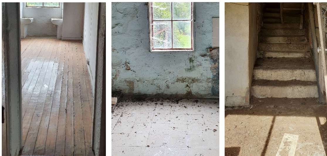
a) Soalho em madeira - habitação 2.
