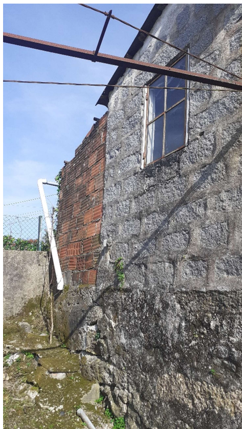
Figura 1 – Alçado posterior em cantaria de pedra.
