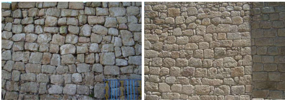
Figura 2.28 – Parede em alvenaria de pedra antes e depois do refeito de juntas (Roque, 2002).
