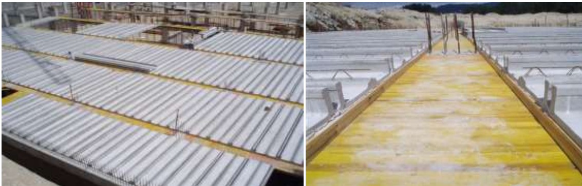
Figura 26 - Lajes com cofragem colaborante – Montagem
