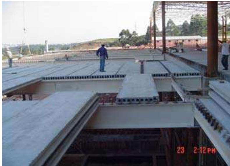
Figura 17 - Painéis Alveolares – Bom acabamento.
