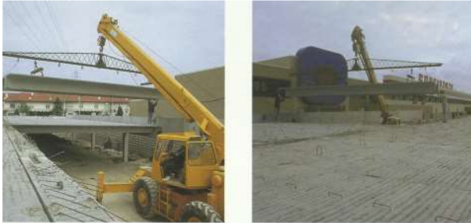
Figura 23 - Lajes Duplo T – Rapidez de execução de pavimentos.
