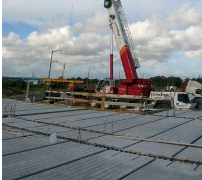
Figura 19 - Pavilhão na Figueira da Foz - Laje Alveolar
