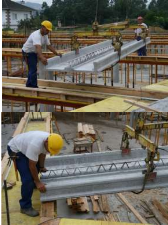
Figura 27 - Lajes com cofragem colaborante - Manuseamento
