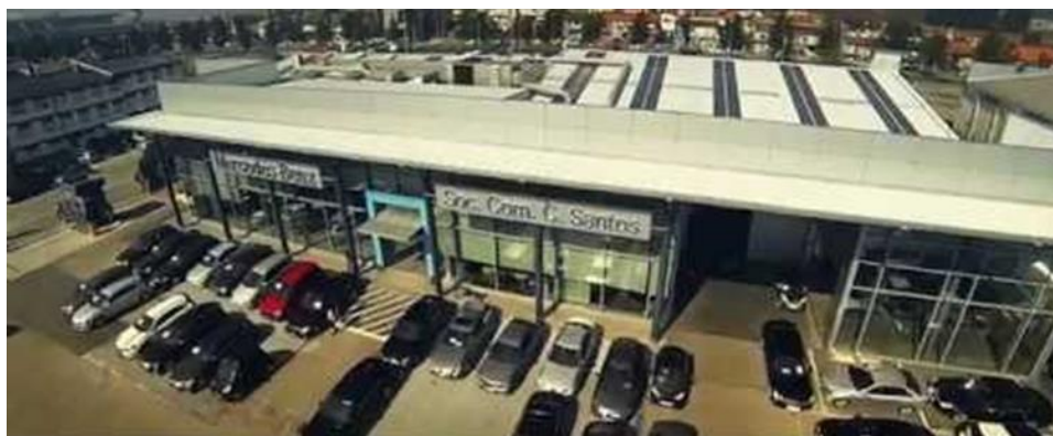
Figura 3 - Instalações na cidade da Maia (C.Santos, 2017).
