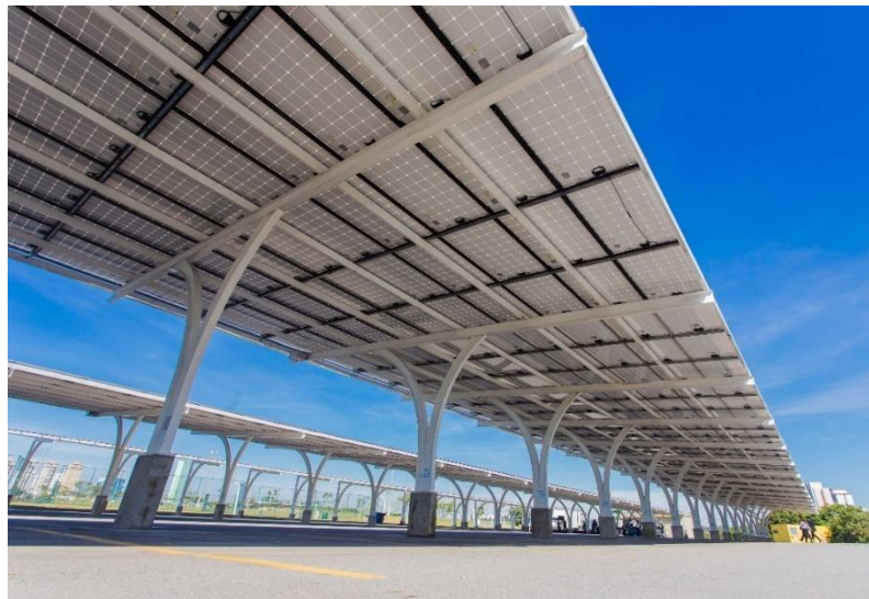
Figura 15 – Carport estacionamento parque Vila Lobos
