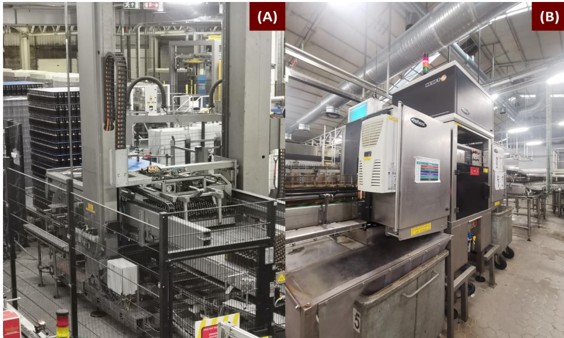
Figura 11 - Equipamentos da linha 2: (A) Despaletizadora; (B) Inspetor de garrafas vazias.
