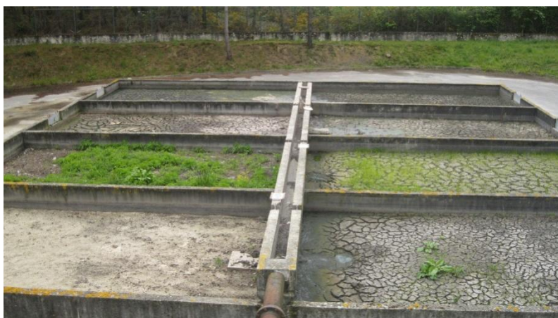
Figura 7.8 - Leitos secagem das lamas da ETAR do parque industrial de Laúndos
