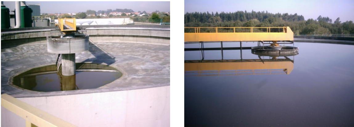
Figura 5.10 - Decantador primário em processo de enchimento e decantador primário cheio, respetivamente (SIMRIA, 2012)
