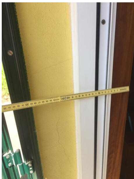
a) Parede exterior em alvenaria de tijolo.
