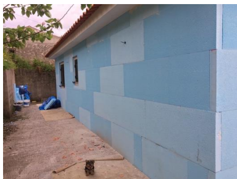
a) Fachada Norte.
