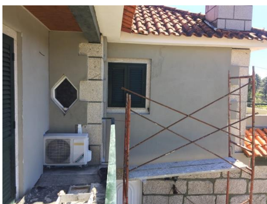
a) Fachada Oeste
