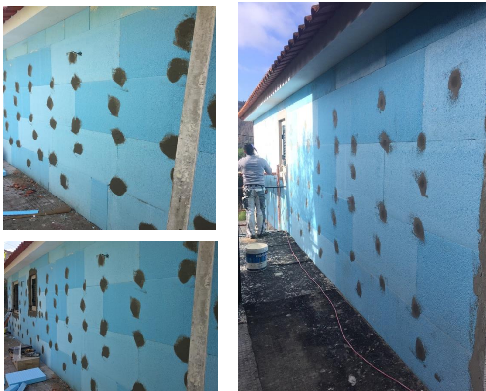
Figura 3.33 – Disposição final das fixações mecânicas nas placas de isolamento XPS.
