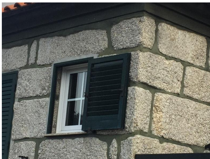
b) Envidraçado Sala/cozinha.
