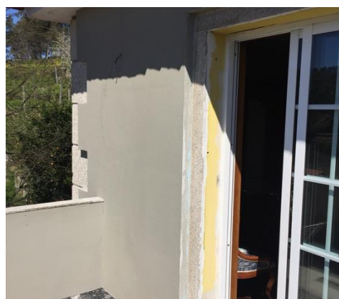
b) Fachada Sul.
