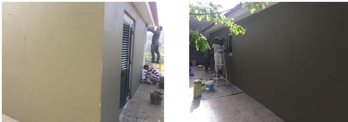
Figura 3.37 – Barramento da argamassa com auxílio da talocha metálica inox.
