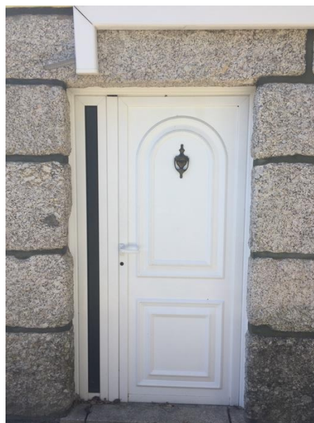
b) Parede exterior em alvenaria de pedra.
