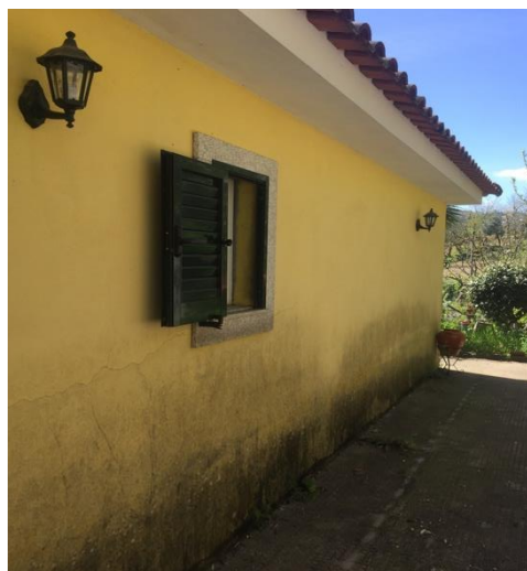
b) Fachada Sul .
