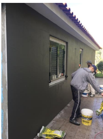
a) Preparação da argamassa.
