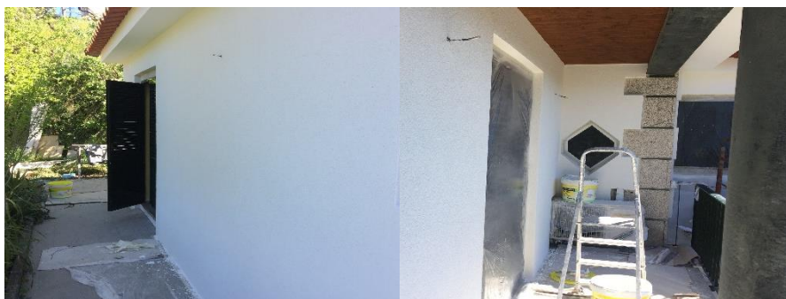
Figura 3.41 – Aparência final das fachadas Oeste e Sul.
