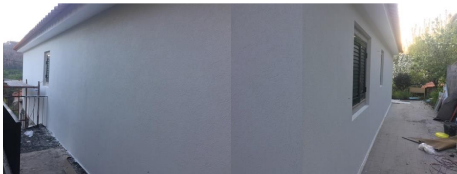
Figura 3.40 – Aparência final das fachadas Este e Norte.
