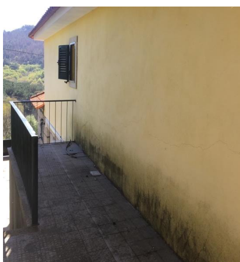
b) Início de remoção dos eflorescentes.
