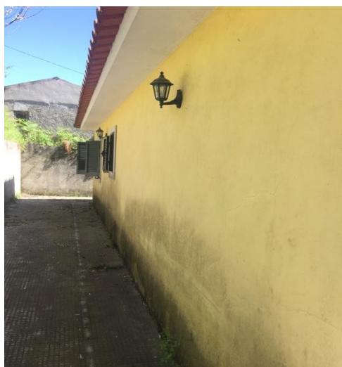
a) Fachada norte.
