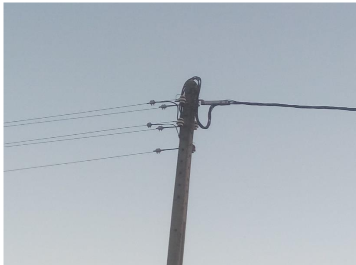
Figura 19 – União entre condutores nus e cabos de torçada
