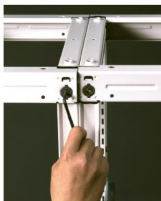
Figura 18 - Montagem do quadro elétrico
