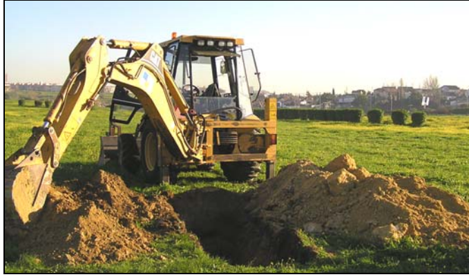
Figura 8.2 – Execução dos poços de amostragem
