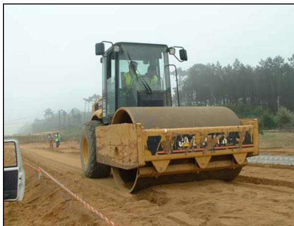
Figura 7.11 – Compactação na fase inicial (cilindro de rolo)
