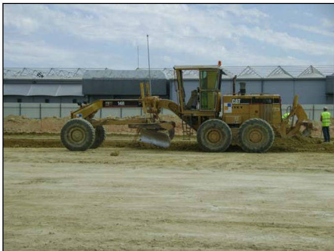
Figura 8.13 – Regularização da camada de fundação
