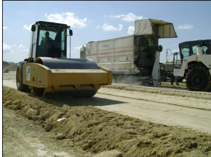
Figura 8.15 – Compactação da camada
