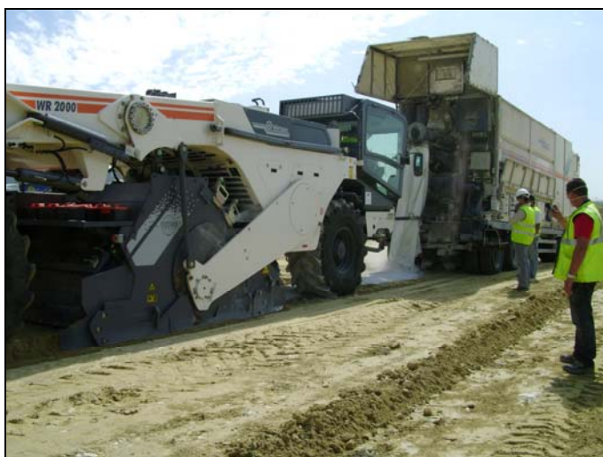
Figura 8.14 – Espalhamento da cal
