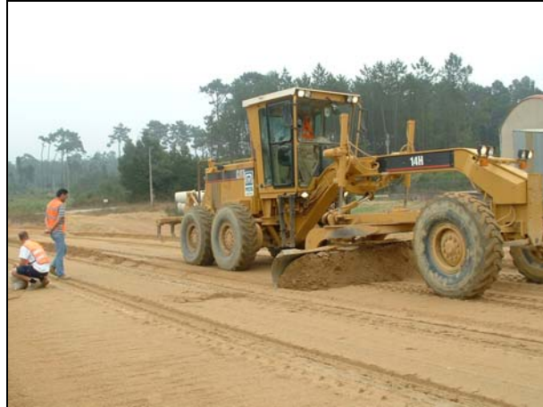
Figura 7.6 – Espalhamento do solo com a motoniveladora
