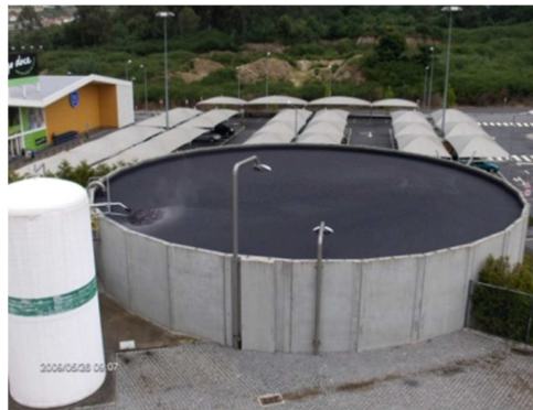
Figura 2.10 - Imagem do tanque de arejamento do tratamento de lamas activadas da Mundotêxtil
