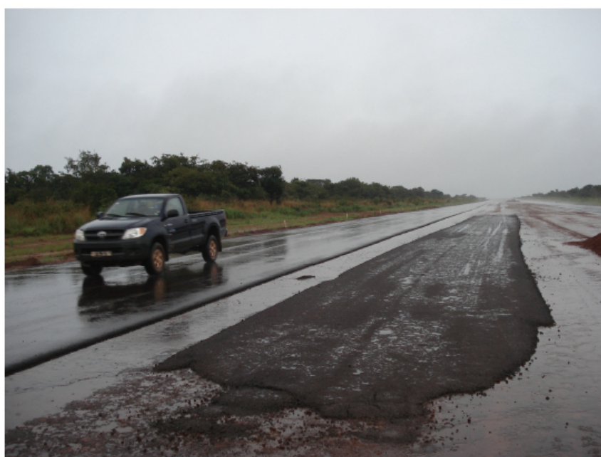
Figura 4.9 – Teste de campo realizados para CPA após chuva forte (Latersolo, 2010)
