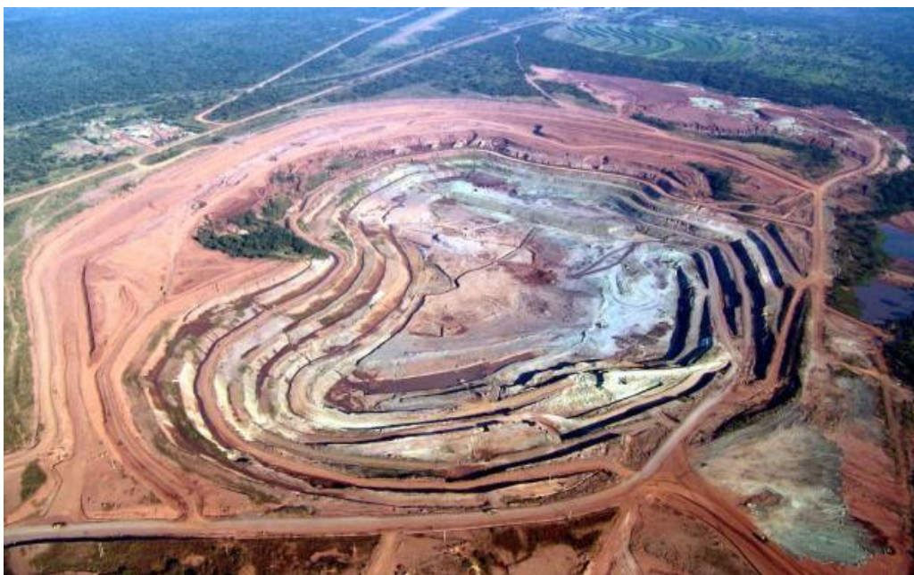
Figura 4.2 – Vista aérea da mina de Catoca (Agência Lusa, 2015)
