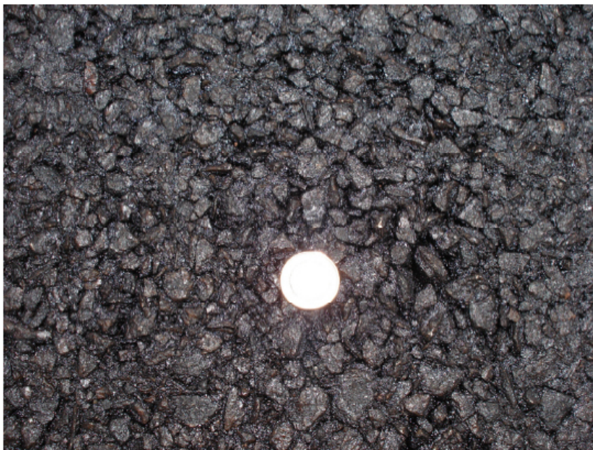
Figura 4.10 – Detalhe da CPA executada no Aeroporto de Catoca (LaterSolo, 2010)
