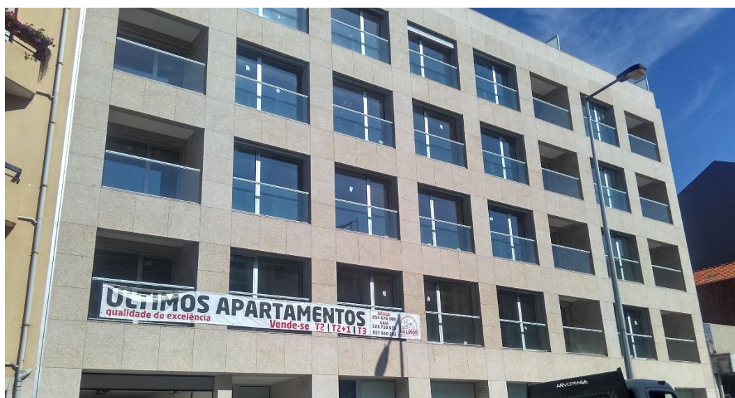
Figura 7 - Vista frontal do empreendimento.
