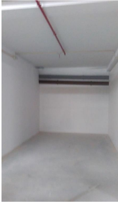
Figura 20 - Vista do lugar de garagem
