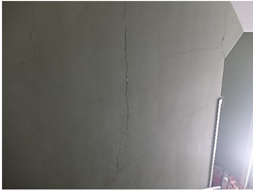
a) Parede da caixa de escada
