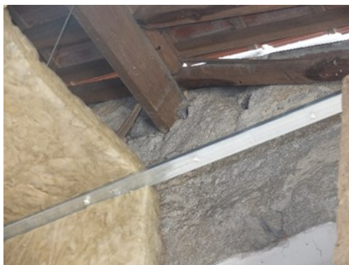
Figura 4.9 – Representação da alvenaria de pedra interior, junto à cobertura
