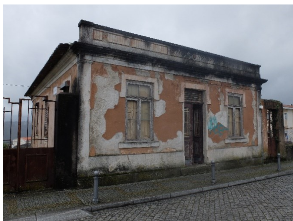
a) fachada do edifício, virada para este
