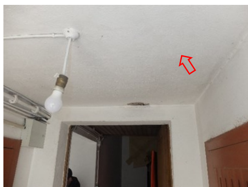
a) Patamar da escada exterior em laje de betão armado
