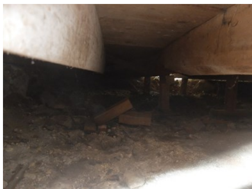
a) Vigas de madeira do piso 0, situadas na zona de caixa de ar
