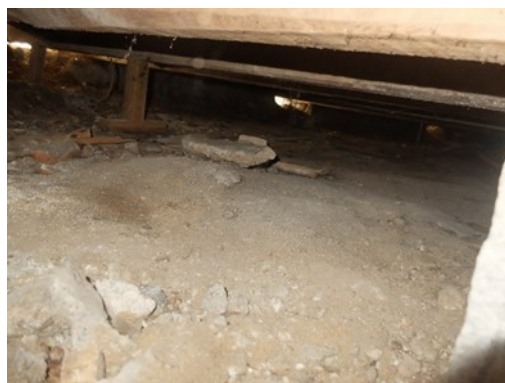
b) Gateiras existentes na base da alvenaria da fachada do corpo sudoeste
