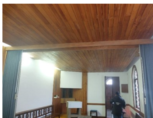
b) Teto em forro de madeira, no corpo lateral nordeste
