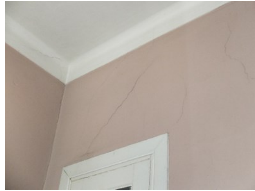
b) Parede interior do piso 2 (corpo posterior)
