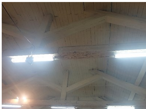
a) Asnas existentes, com forro de madeira nas faces das peças
