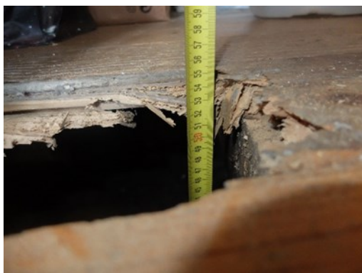
a) Caixa-de-ar existente no pavimento em madeira com altura média de 0.55m
