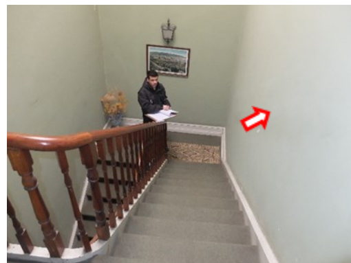
d) Parede de suporte dos vários lanços de escadas (piso 2)
