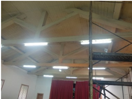
a) Asnas da cobertura em madeira
