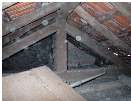
e) Vista geral da asna secundária
