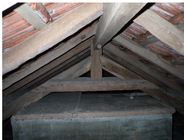
c) Vista geral da asna envolvente ao reservatório
