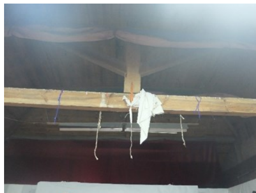
b) Asna existente, sem forro de madeira
