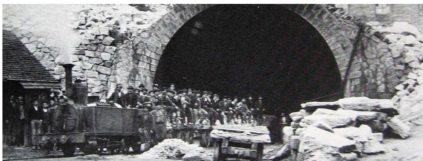
Figura 22 – Inauguração do Túnel Gotthard, 1882 [89]
