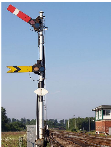
Figura 19 – Sinalização “braço” articulado, atualmente [80]
