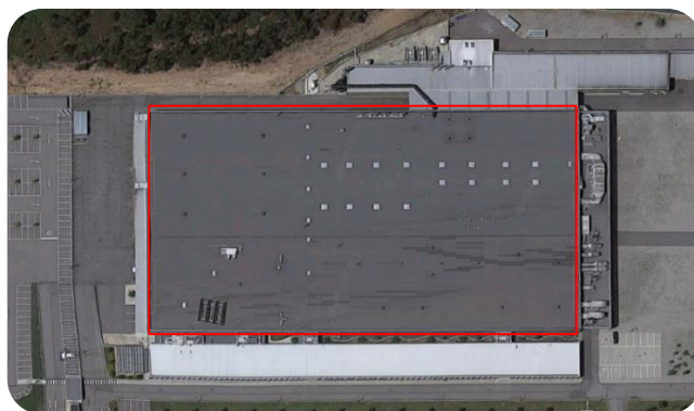
Figura 3-14 – Área para instalação dos painéis fotovoltaicos
