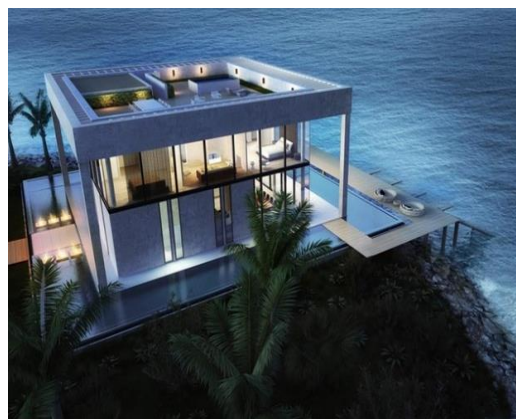
Figura 7 - Exterior de uma Water Villas Fonte: Site Zaya Nurai Island
