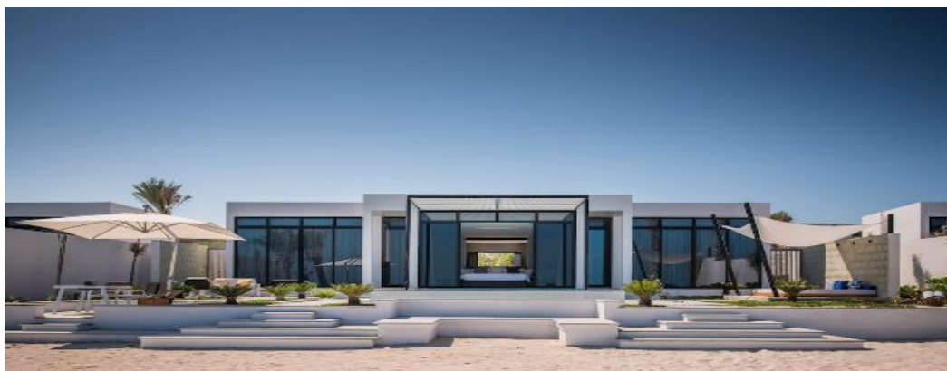
Figura 4 - Exterior de uma Beach Villa Fonte: Site Zaya Nurai Island
