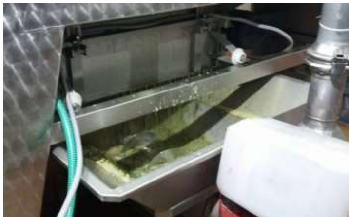
Figura 3.5 - Bomba Elevação de massas (mostos).
