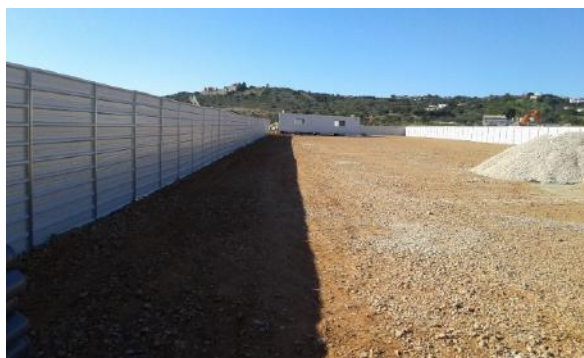
Figura 7.15 - Vedação da obra de cor clara
