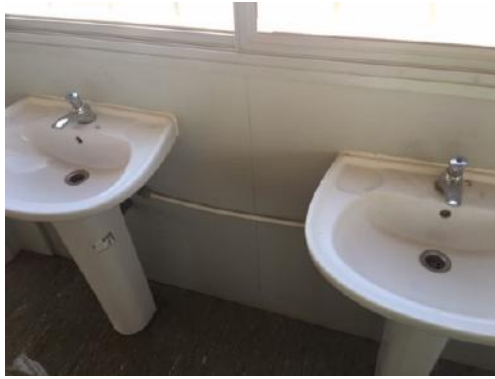
Figura 7.24 - Torneiras com temporizadores
