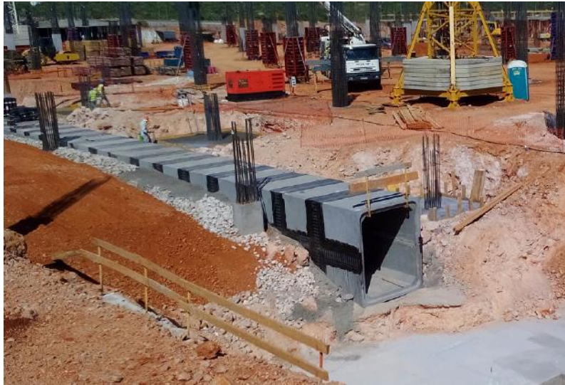
Figura 5.9 – Colocação de betão ciclópico nas laterais
