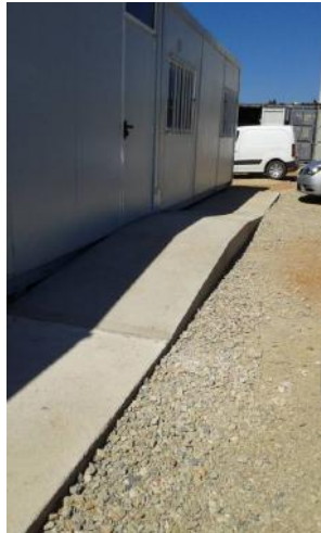
Figura 7.7 - Rampa de acesso para pessoas com mobilidade reduzida
