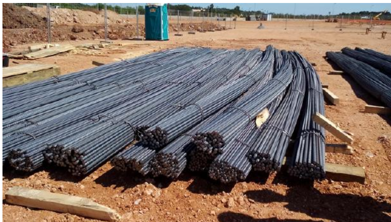
Figura 5.18 - Aço empregue em obra
