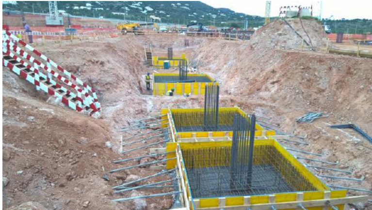
Figura 5.25 - Cofragem de sapatas
