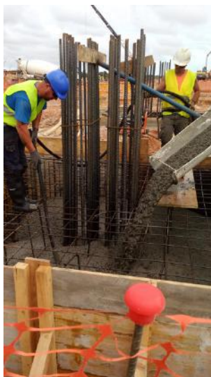
Figura 5.33 - Betonagem de sapata
