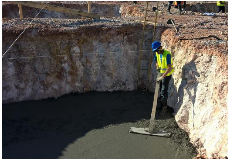
Figura 5.13 - Regularização do betão de limpeza
