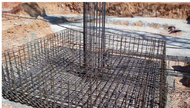
Figura 5.20 - Armadura de sapata
