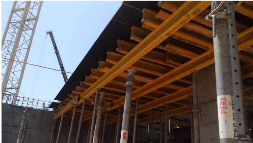
Figura 5.27 - Prumos e painéis para cofragem de lajes
