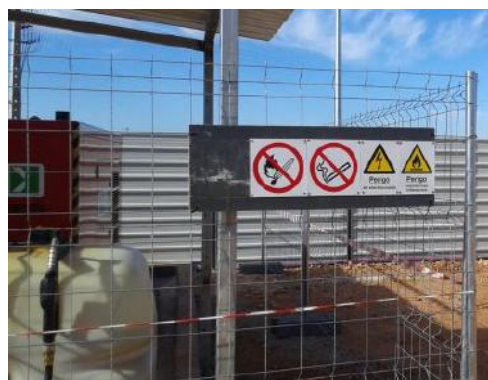
Figura 7.9 - Sinalização dos riscos junto ao depósito de combustível
