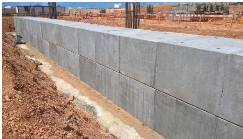
Figura 5.7 – Assentamento das peças
