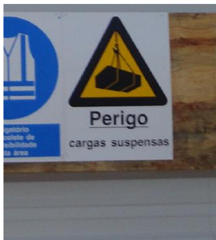
Figura 7.8 - Sinalização de riscos à entrada da obra
