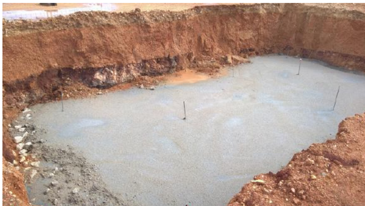
Figura 5.17 - Aspeto final com a regularização da superfície
