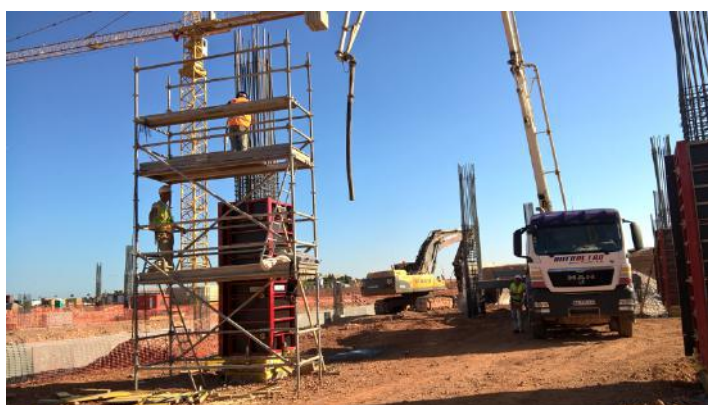
Figura 5.34 - Betonagem de pilar
