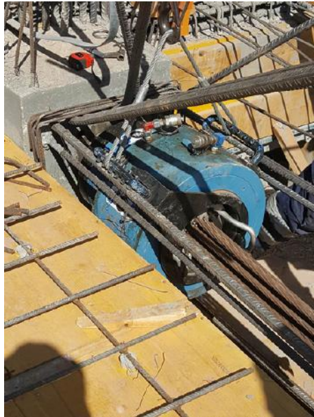
Figura 5.51 - Fixação do macaco hidráulico
