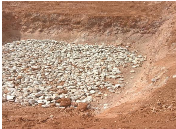
Figura 5.15 - Colocação das pedras no fundo da sapata
