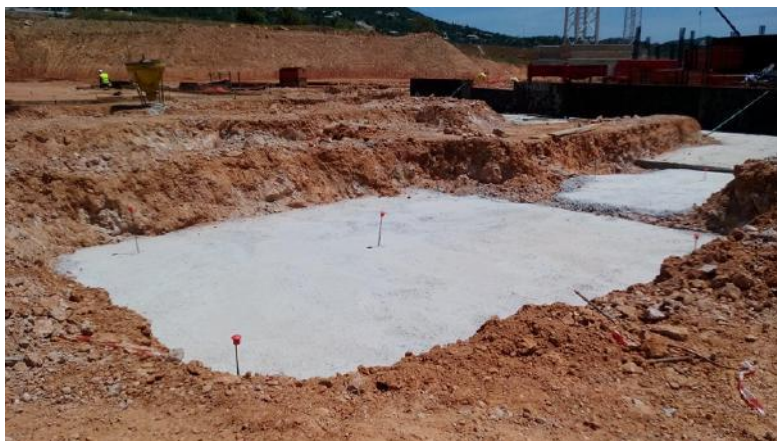
Figura 5.14 - Betão de limpeza para arranque das estruturas de fundação
