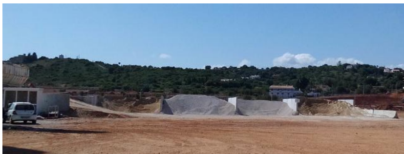
Figura 4.2 – Alguns dos materiais constituintes do betão na central de betão
