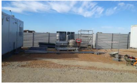
Figura 7.29 - Parque de materiais delimitado
