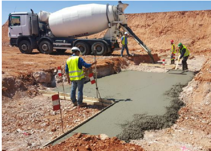
Figura 5.12 - Descarga do betão de limpeza nos elementos de fundação
