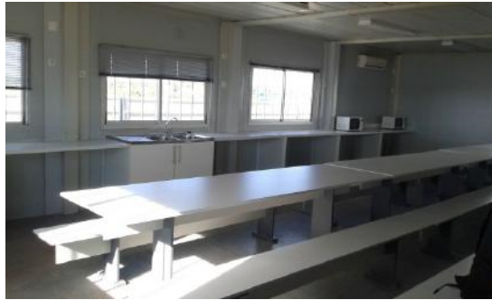
Figura 7.18 - Refeitório da obra
