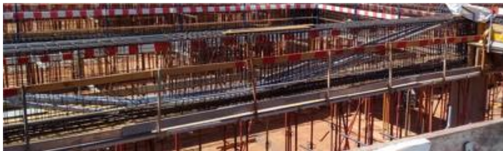
Figura 5.43 - Posicionamento de bainhas de cabos em viga
