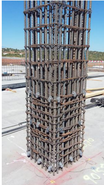
Figura 5.21 - Armadura de pilares
