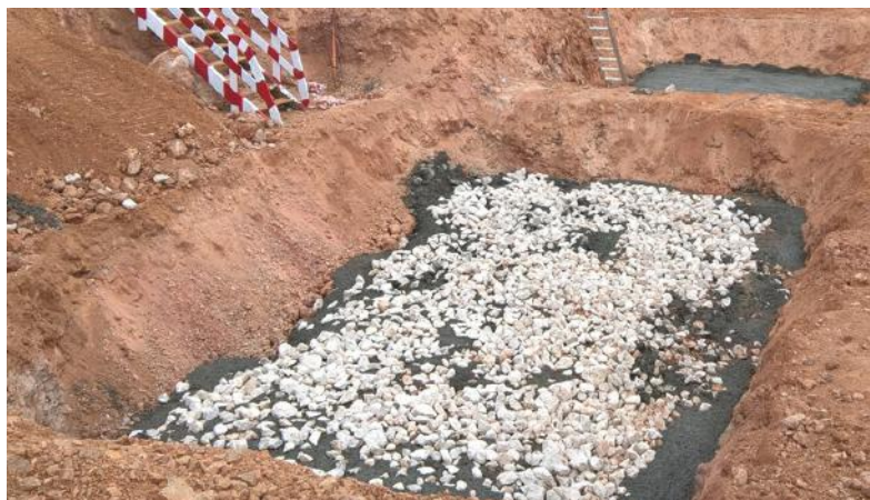
Figura 5.16 - Adição de betão
