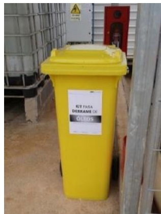
Figura 7.26 - Kit de contenção de derrames junto ao depósito de combustível
