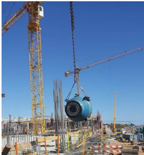
Figura 5.49 - Transporte do macaco hidráulico
