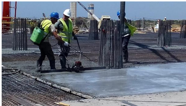
Figura 5.37 - Betonagem da laje. Espalhamento do betão
