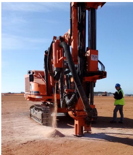
Figura 3.4 - Execução da perfuração
