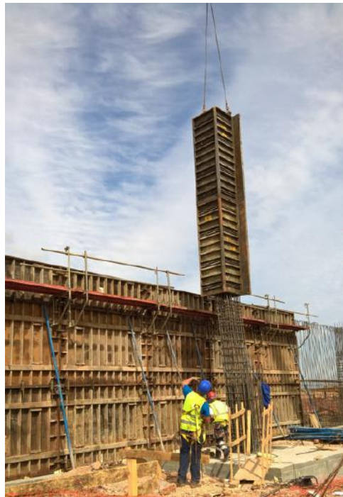
Figura 5.26 - Cofragem de pilar
