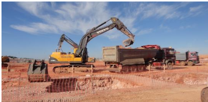
Figura 3.5 - Escavadora rotativa equipada com balde
