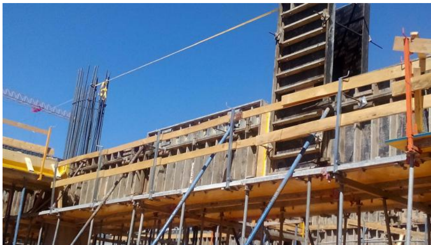
Figura 5.28 - Cofragem de viga
