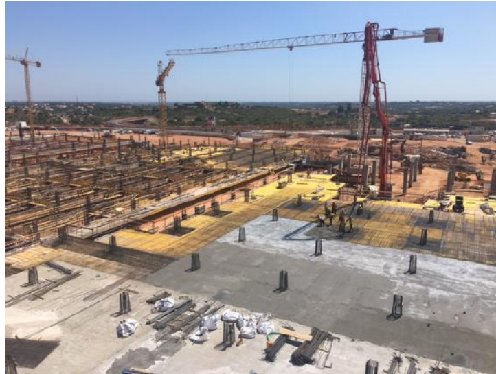
Figura 5.36 - Betonagem de laje. Aplicação do betão
