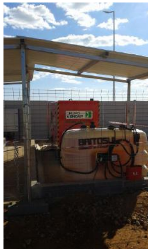
Figura 7.28 - Telheiro no depósito de combustível
