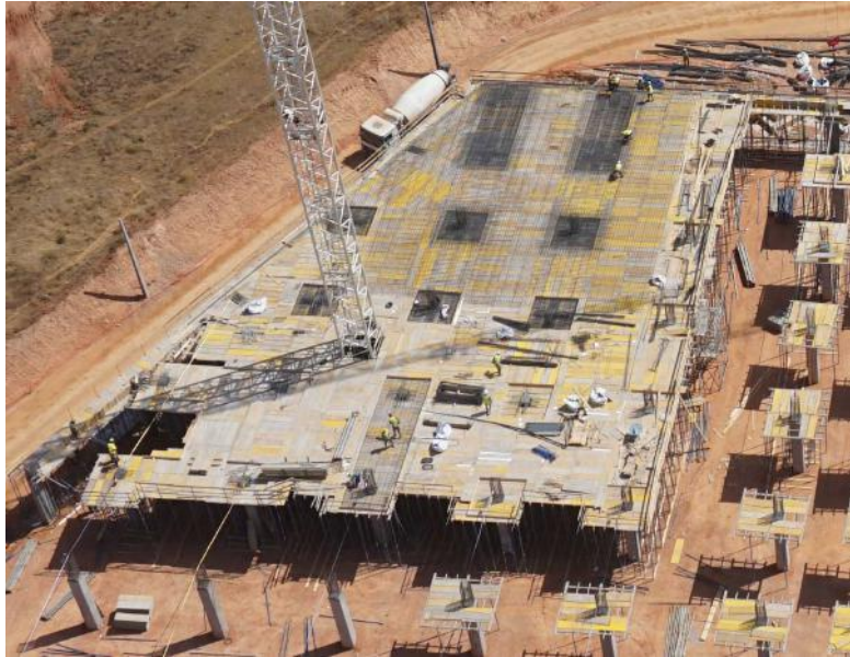
Figura 5.5 - Preparação para execução de laje fungiforme
