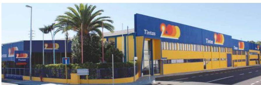
Figura 1 - Fábrica de Tintas 2000, S.A. – Sede e Fábrica (‘Fábrica de Tintas 2000’, 2017).
