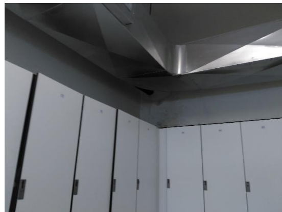
b) Infiltração na parede em contacto com terra.
