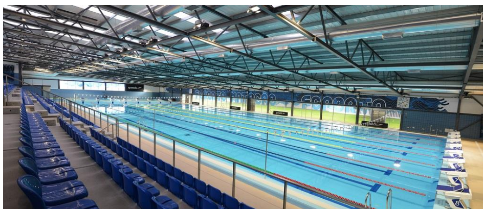
Figura 3-3 – Piscina de Campanhã – vista da zona da nave (FC Porto, 2016).
