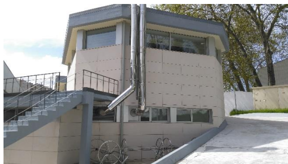
b) Vista edifício de apoio.
