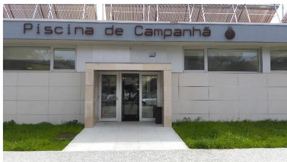
a) Entrada principal do edifício de apoio.
