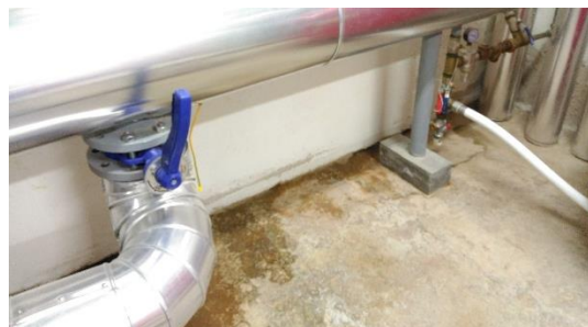
Figura 3-11 – Pavimento da zona técnica.
