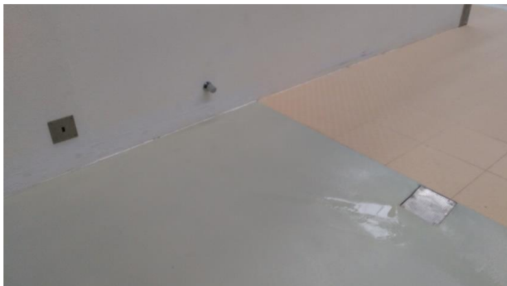
Figura 3-6 – Revestimento do pavimento da passagem da zona de lava-pés para a nave.
