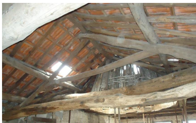
Figura 2.6 - Coberturas de edifícios do Centro Histórico do Porto, vista do interior
