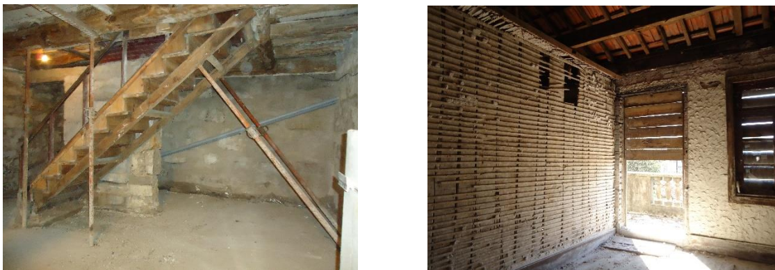
Figura 2.2 – Paredes divisórias interiores de pedra e em tabique com ripado visível
