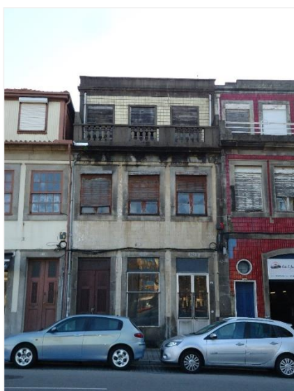
a) Fachada Principal (W), antes da intervenção
