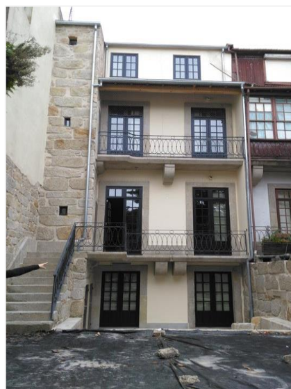
d) Fachada Posterior (E), depois da intervenção
