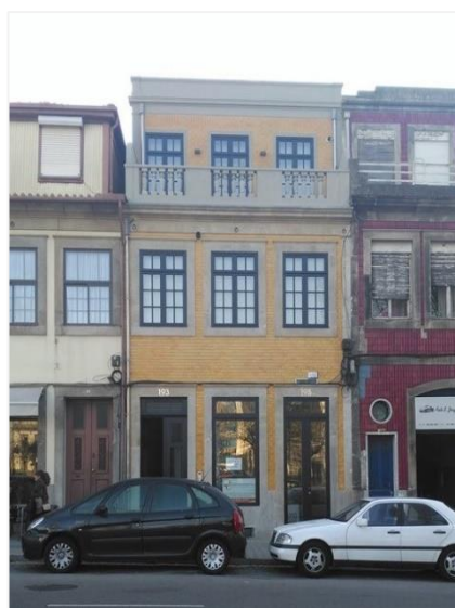
b) Fachada Principal (W), depois da intervenção
