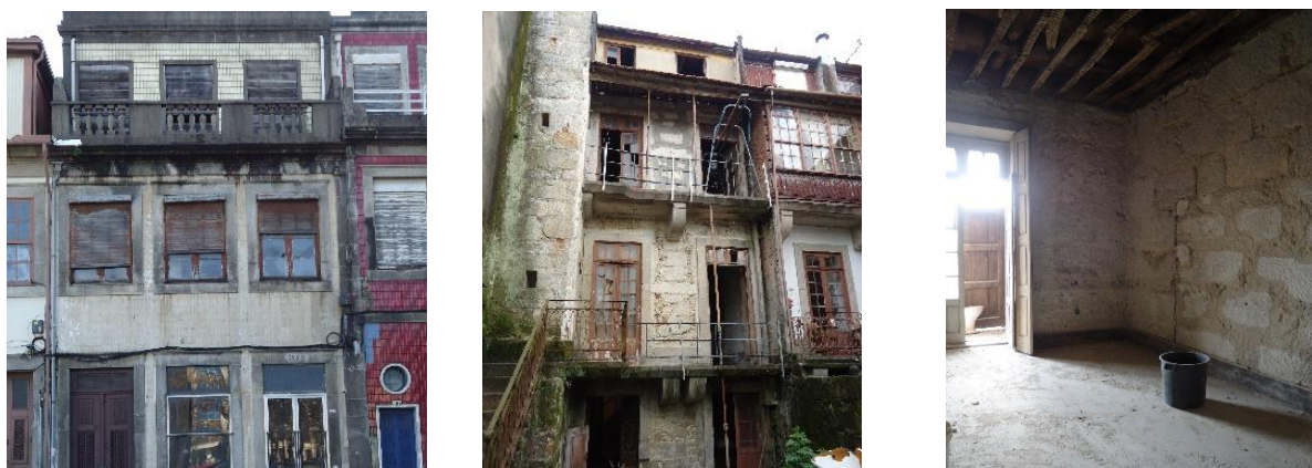
Figura 2.1 – Fachada principal, fachada posterior e parede de meação em pedra de granito
