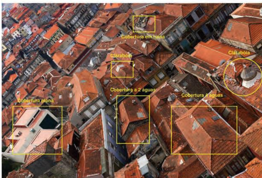
Figura 2.5 - Coberturas de edifícios do Centro Histórico do Porto (5)
