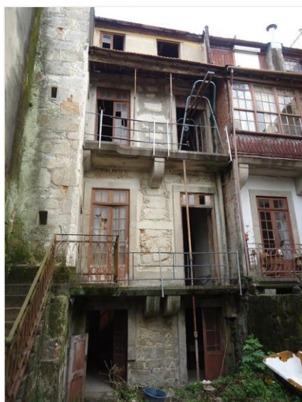
c) Fachada Posterior (E), antes da intervenção
