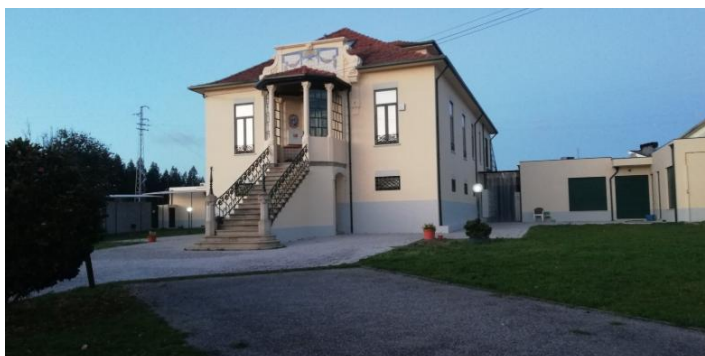
Figura 150: Fotografia da Fundação
