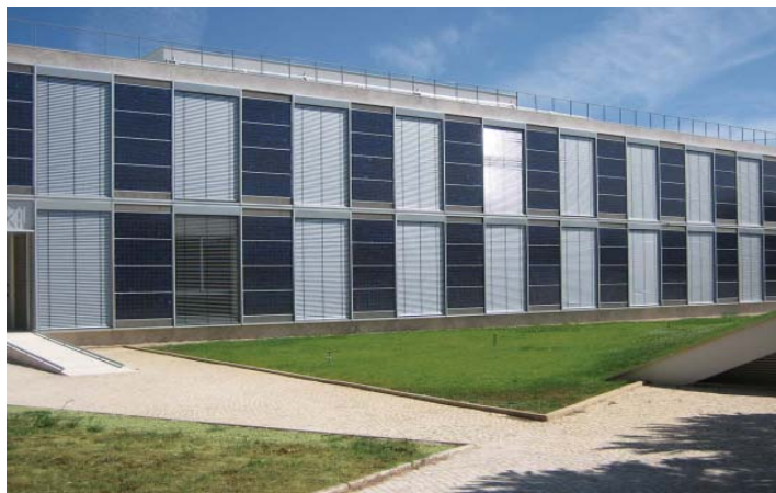
Figura 2: Edifício LNEG em Portugal [44]
