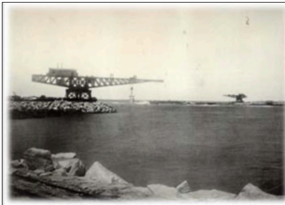
Figura 4 - Construção do Porto de Leixões (1884-1892). Rochedos de Leixões e extremidades dos dois molhes. Foto: Emílio Biel. (APDL).
