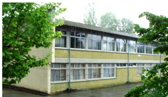
Figura 3. ESQF antes da intervenção.
