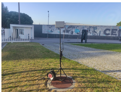
(a) Zona de instalação do sistema
