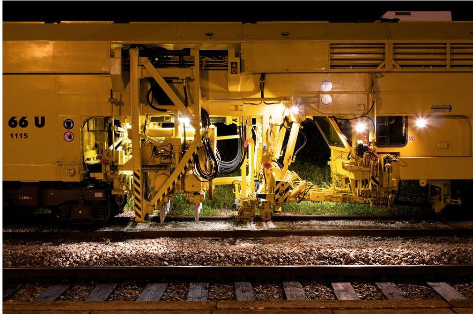
Figura 98 – Atacadeira de via (Somafel) a executar trabalhos na linha do sul (Fonte: Nuno Morão – flickr)
