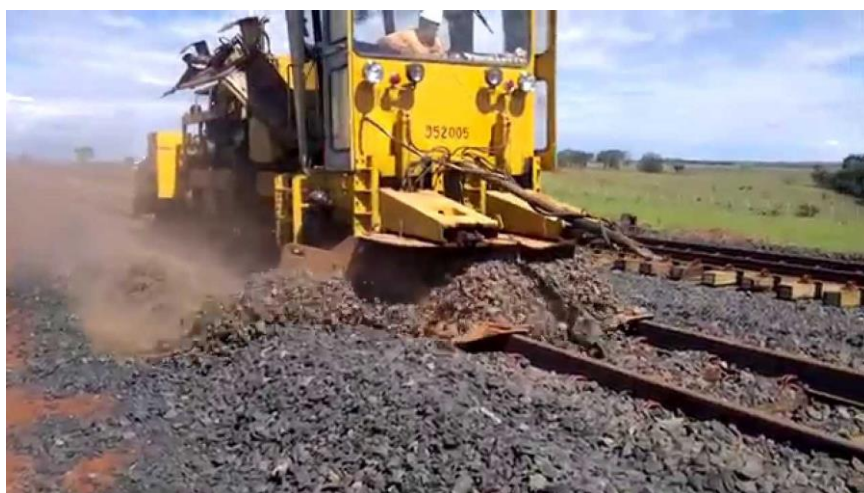
Figura 99- Reguladora numa primeira passagem (Fonte: Máquinas FERGRUPO)
